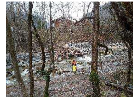
Entretien de la végétation dans le torrent du Bayet à Saint-Paul-sur-Isère
