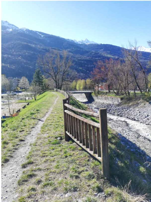
Système d'endiguement de l'Arbonne, Bourg-Saint-Maurice
