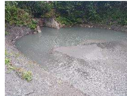
Plage de dépôt du torrent du Charbonnet à Bourg-Saint-Maurice
