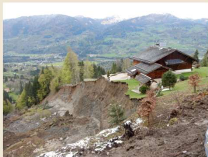
Glissement à Samoëns en 2016 Photo ONF-RTM 74
