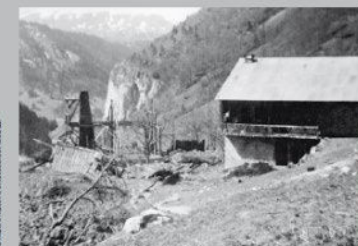
Maison détruite au hameau de Malastrax. A destroyed house in the Malastrax hamlet.
