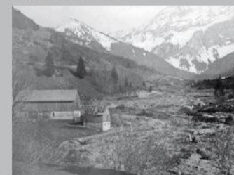
Coulée de boue au hameau Le Cerny. The mudflow in the Le Cerny hamlet.
