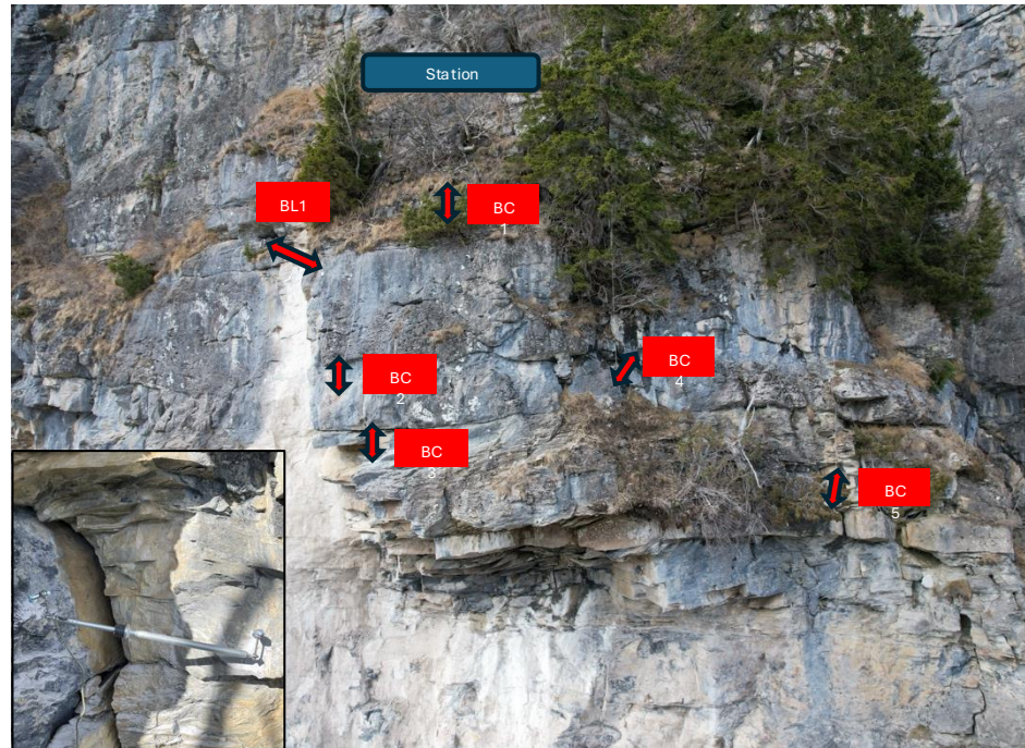
Dispositif extensométrique installé
