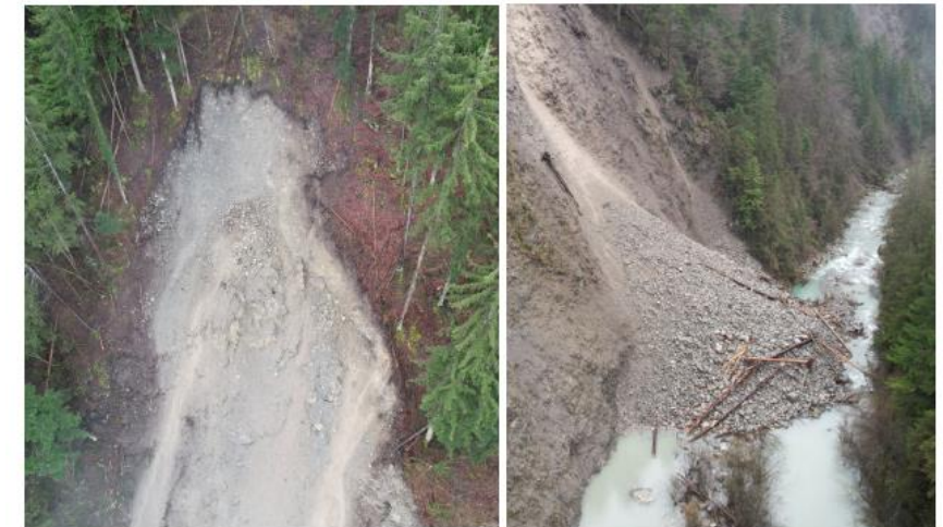
Vues drone du 20/02/26 après le second évènement du 16/02/26 En haut : Vue générale / En bas à gauche : Détail de la zone de départ / En bas à droite : Cône d'éboulis dans le lit de la Dranse
