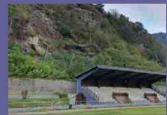
Filets de protection installés à l'arrière du stade Jo Fessler, 29 octobre 2021
