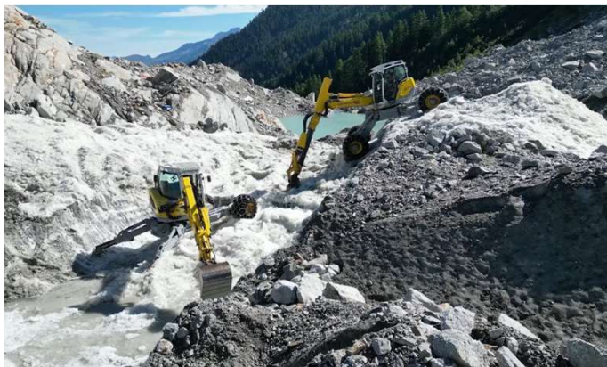
Travaux de vidange du lac glaciaire des bossons Eté 2023
