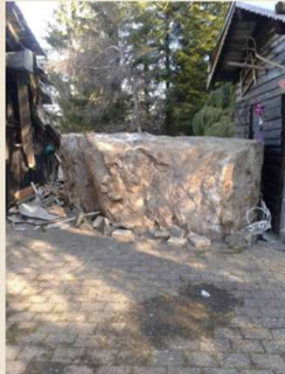
Chute de bloc à Morzine en 2013 Photo ONF-RTM 74
