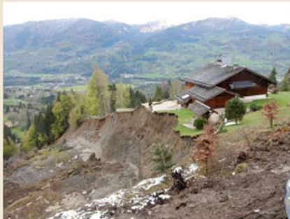
Glissement à Samoëns en 2016 Photo ONF-RTM 74
