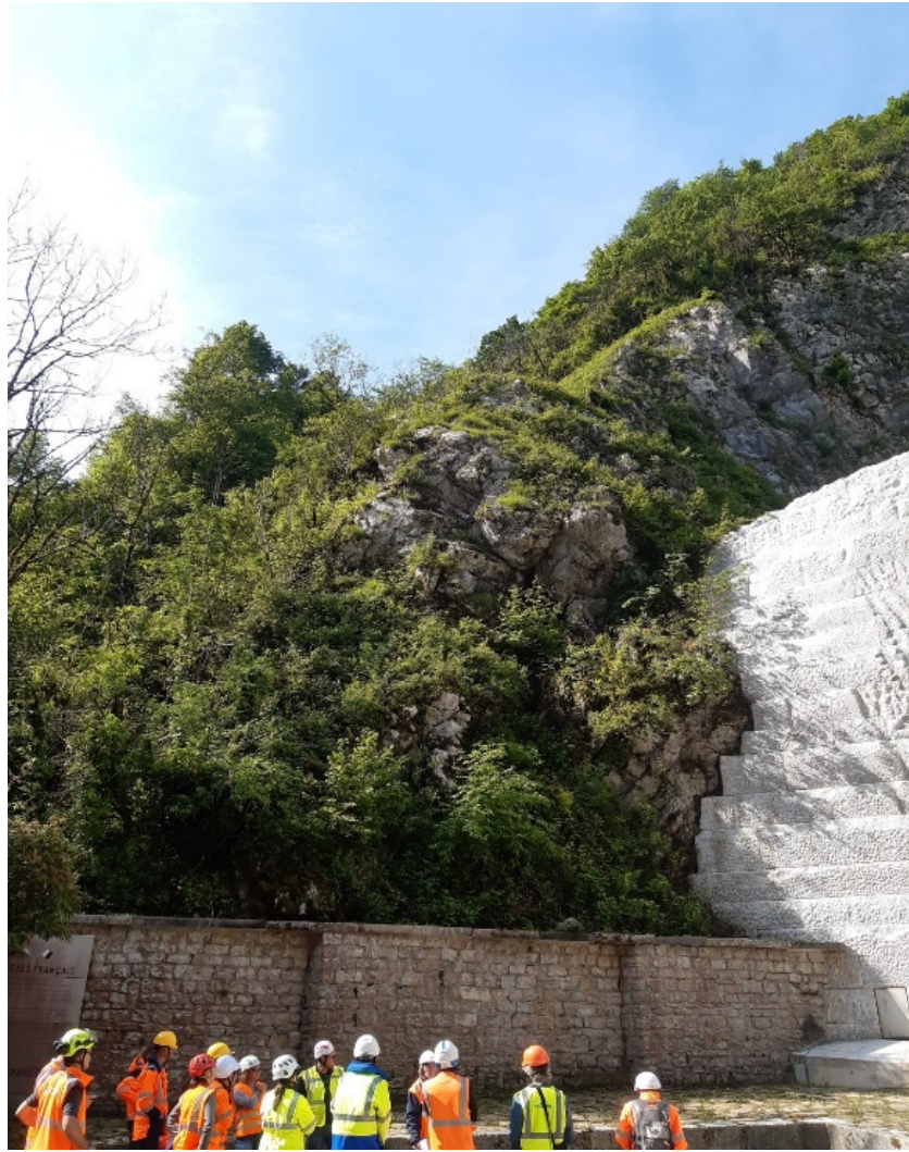
Figure 3b : Versant conforté site du Monument (©Cerema)
