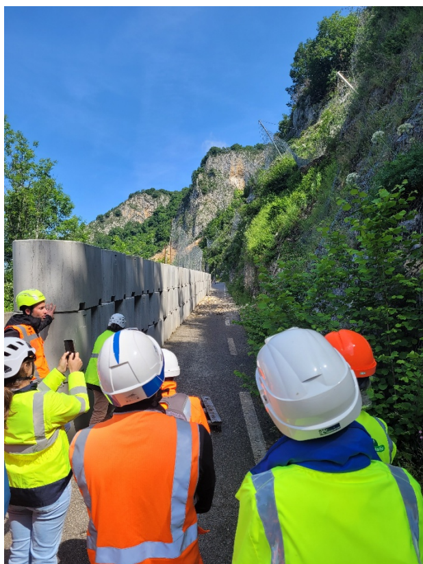
Figure 6b : Couloir éboulement 2023 (©PARN)
