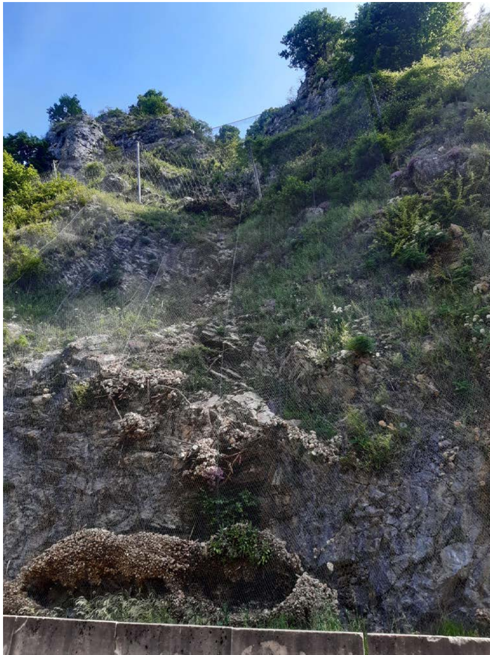
Figure 4 : Couloir éboulement 2022 (©Cerema)
