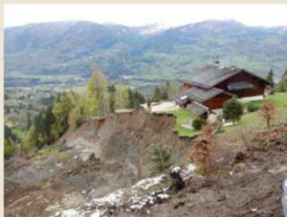
Glissement à Samoëns en 2016 Photo ONF-RTM 74
