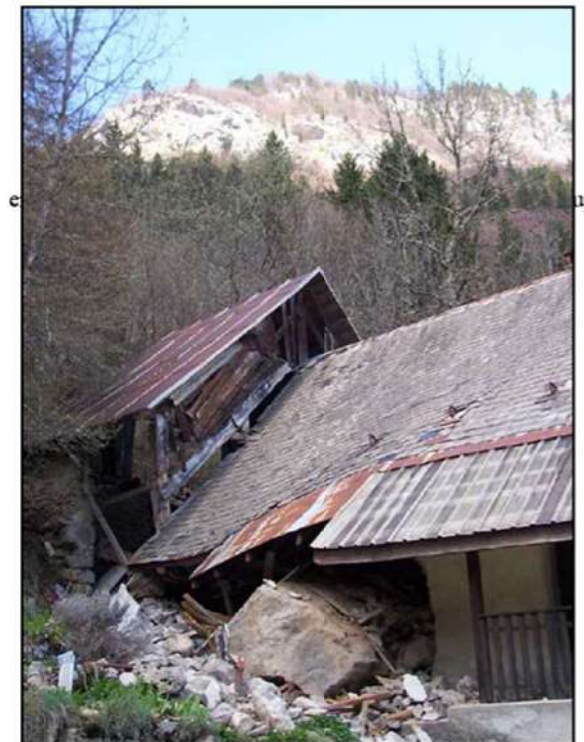
Figure 18: Un des chalets de Saint-Ruph atteint par un bloc en 2009. A l'arrière-plan, les falaises qui constituent la zone de départ des blocs.
