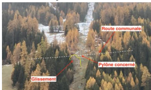
Glissement de terrain de novembre 2023 au niveau du Télésiège de la Roche (La Plagne)
