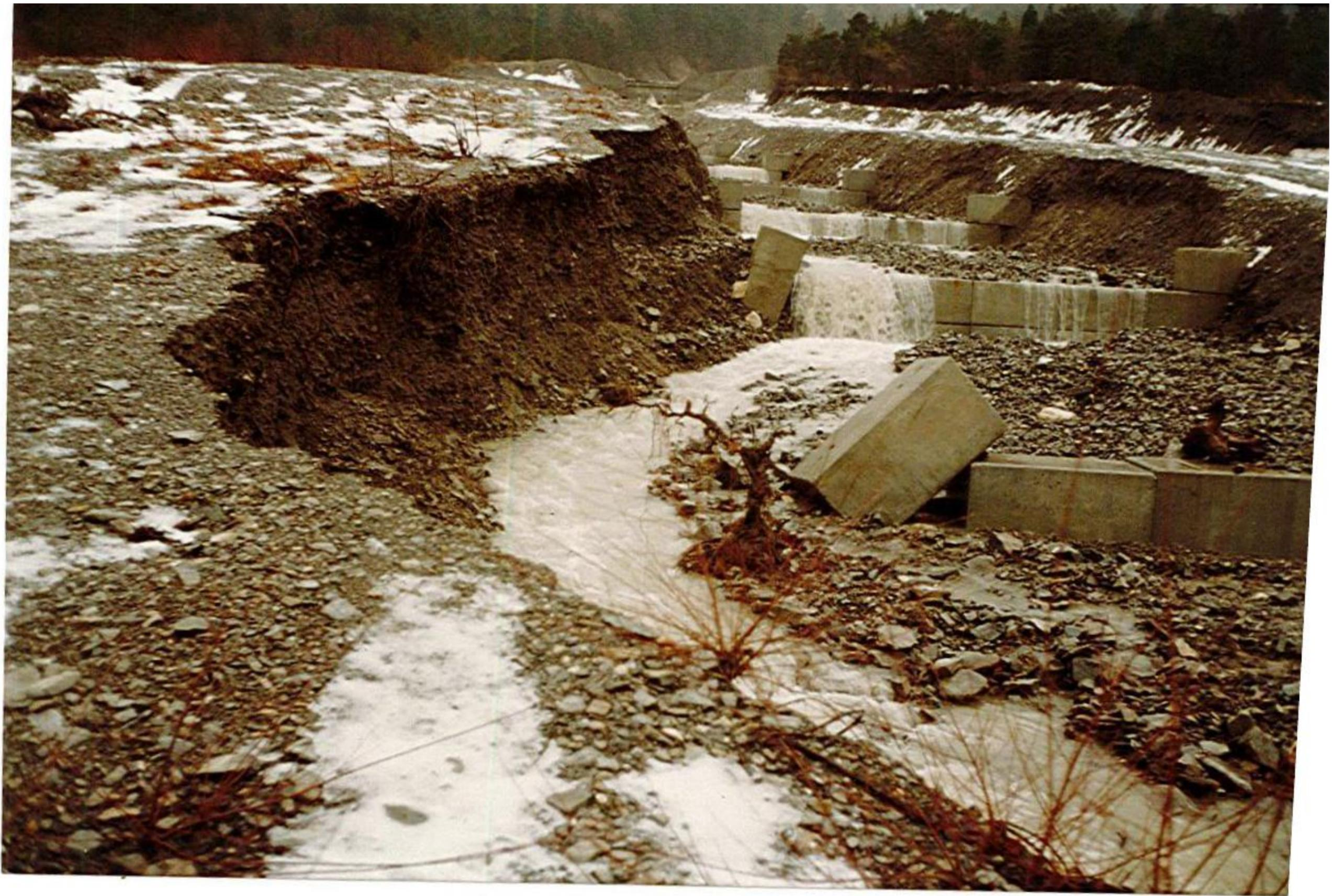
Figure 29 : Contournement de barrages lors de la crue de 1990
