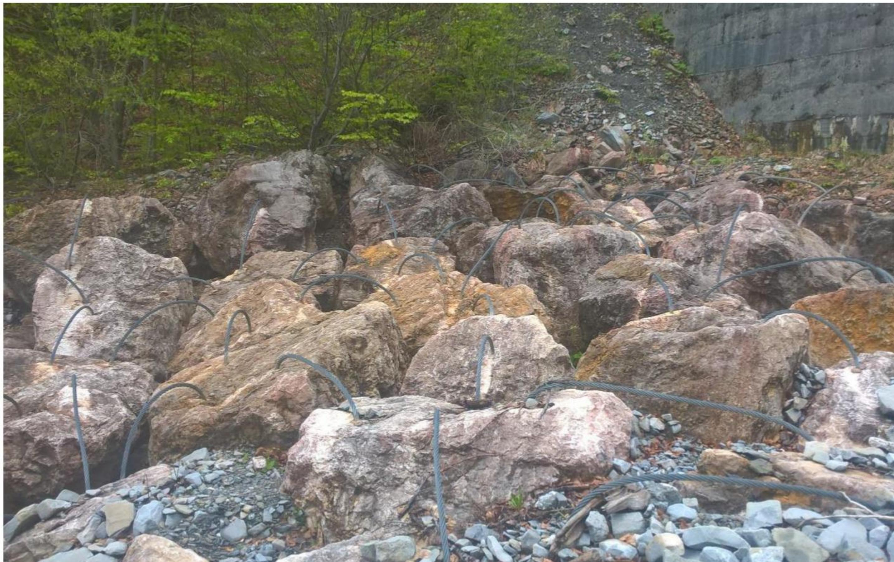
Figure 18 : Radier en blocs câblés à l'aval de l'ouvrage B25.
