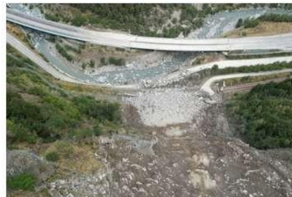
Eboulement de la Praz. Source : CD73
