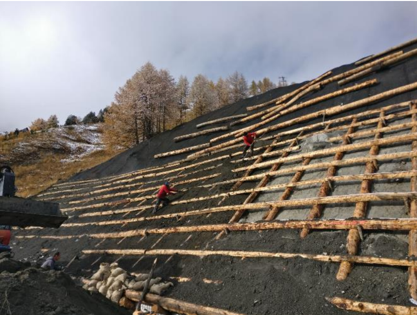
Remplissage terre végétale
