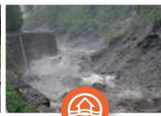
Crues Inondations Erosion
