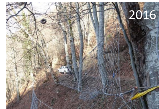
Filets de protection ancrés sur des arbres
