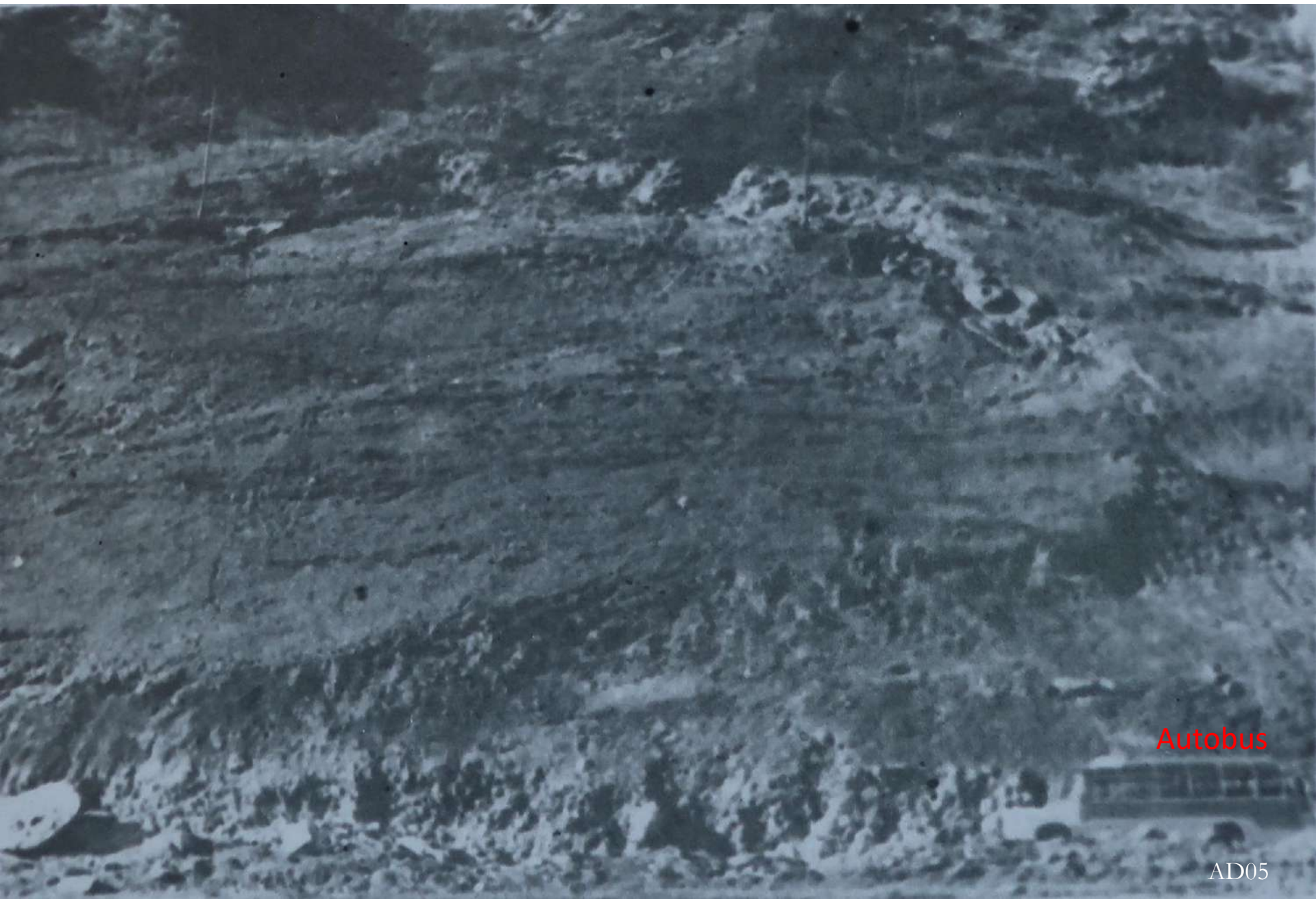
Photo du glissement déclenché par la rectification de la route dans la gorge amont de Ville-Vieille, 1959
