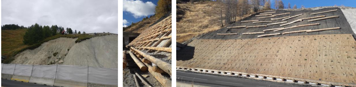
Stabilisation d'un talus par Gratta Viva (avant/pendant/après : 2022-2023) à Tignes (RD 87A)
