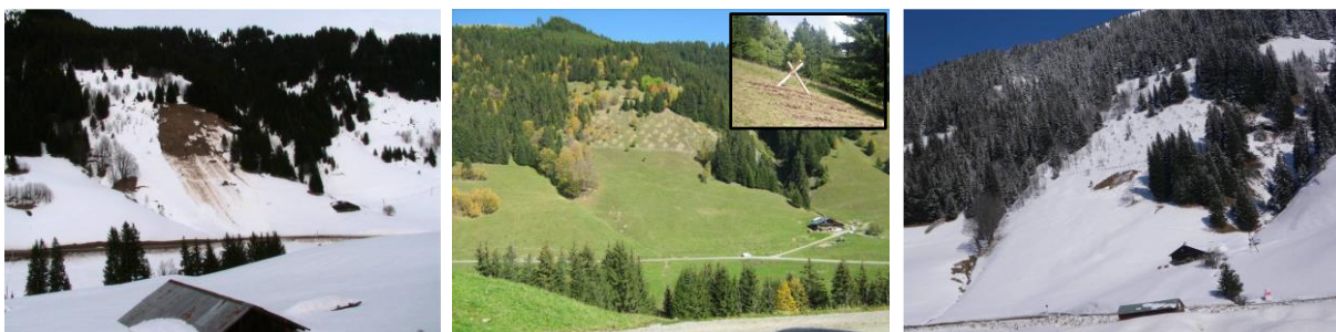
Traitement de coulée de neige par reboisement à l'aide d'un trépié à la française (avant/pendant/après) à Plan Dernier (RD 218B)
