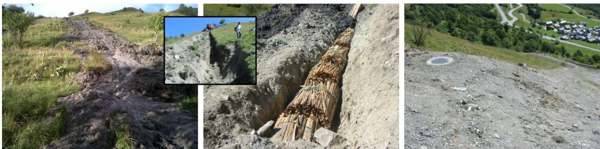
Drainage d'un versant par fagots de bois enterrés associés à des récupérateurs d'eau (avant/pendant/après), Le Levassaix (RD 117)
