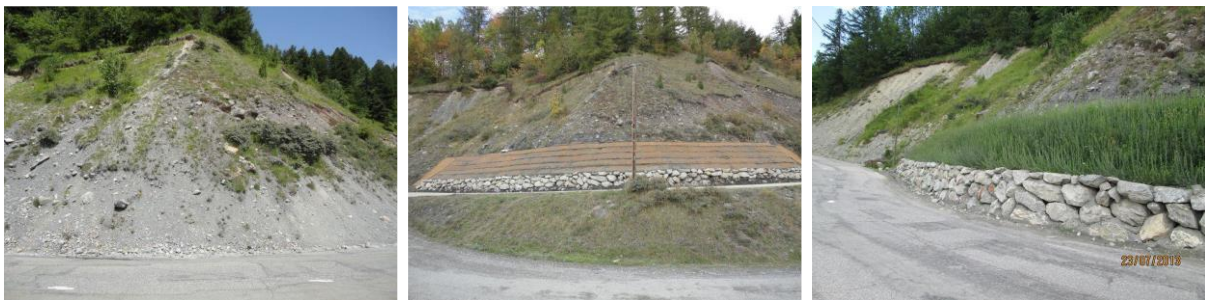
Stabilisation d'un glissement superficiel par lit de plançons (avant/pendant/après) à Albiez-le-Jeune (RD 80)
