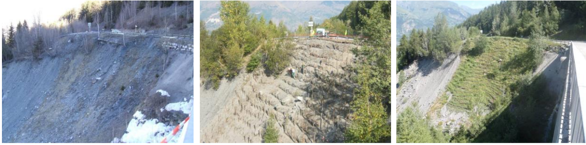
Stabilisation d'un glissement superficiel par fascinage (avant/pendant/après) dans la Ravine de la Ravoire (RD 119)
