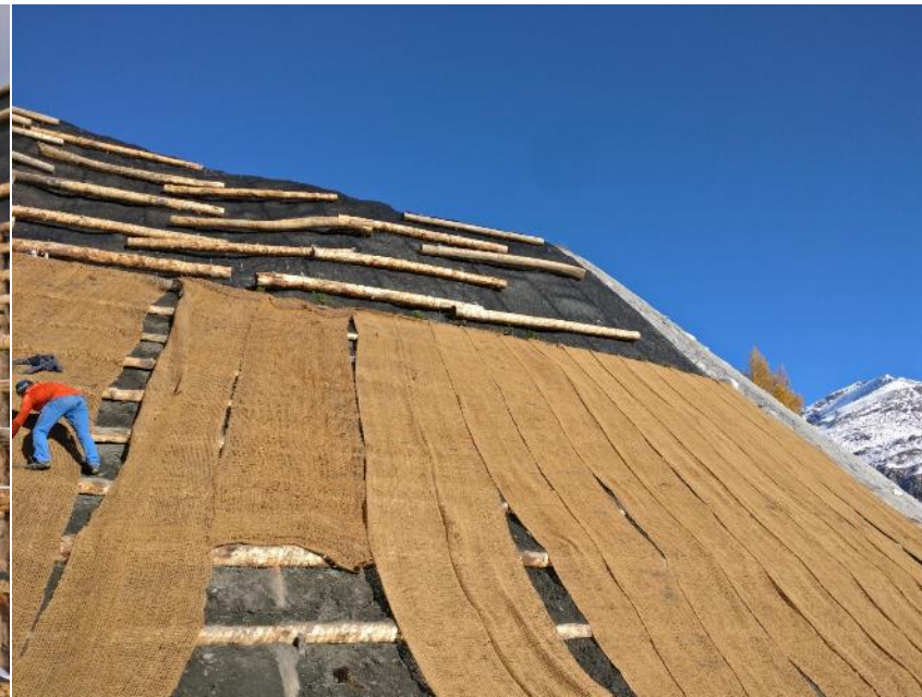
Mise en place toile coco
