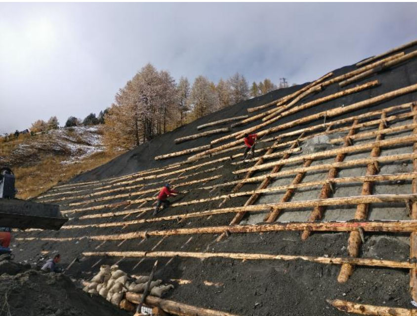
Remplissage terre végétale
