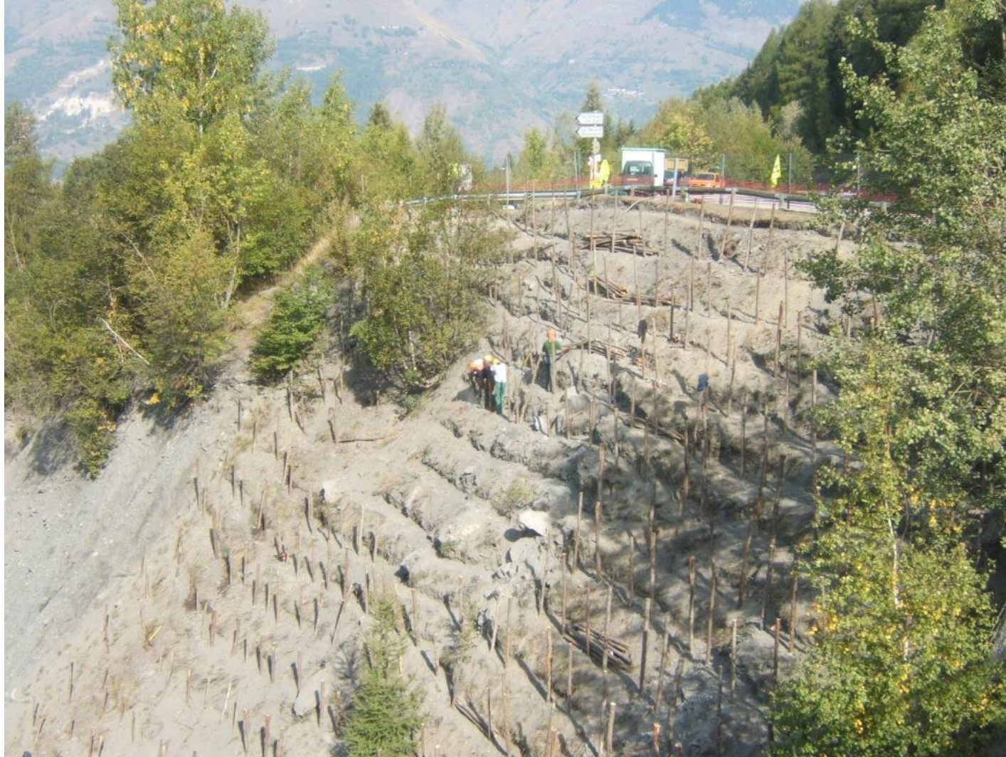
Banquettes et pieux
