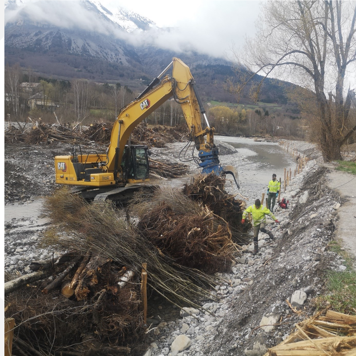
Disposition et ancrage des fagots d'embâcles
