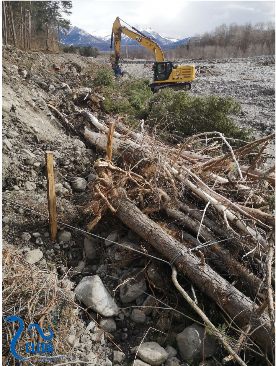
Disposition et ancrage des fagots d'embâcles
