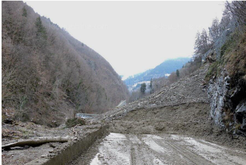
Figure 19 : évènement du 12 janvier 2018 vu depuis le fond de vallée de l'Arly à hauteur de la RD1212 coupée
