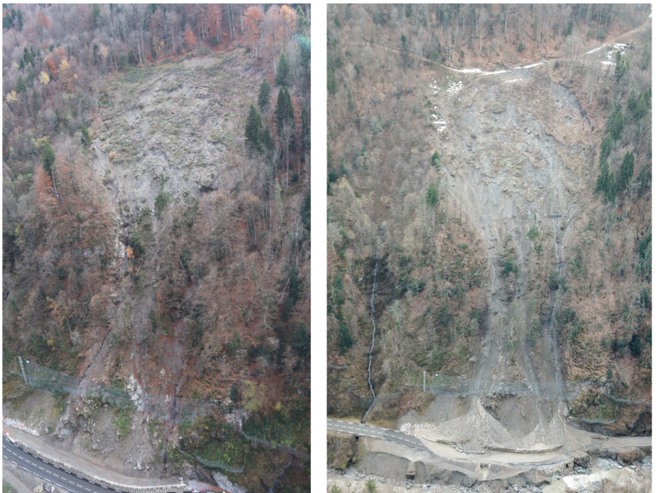
Figure 18 : évolution du glissement de Montgombert entre novembre 2017 à gauche et janvier 2018 à droite (rapport SAGE RP7081c)
