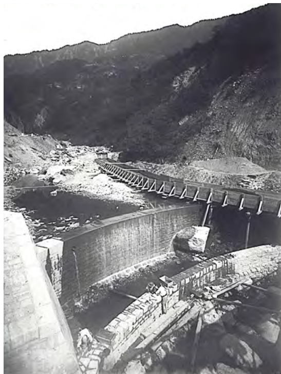
Figure 17 - Photo du chantier de construction des barrages seuils sur l'Arly, 1904 (RTM 73, Kod F4CD3_81)
