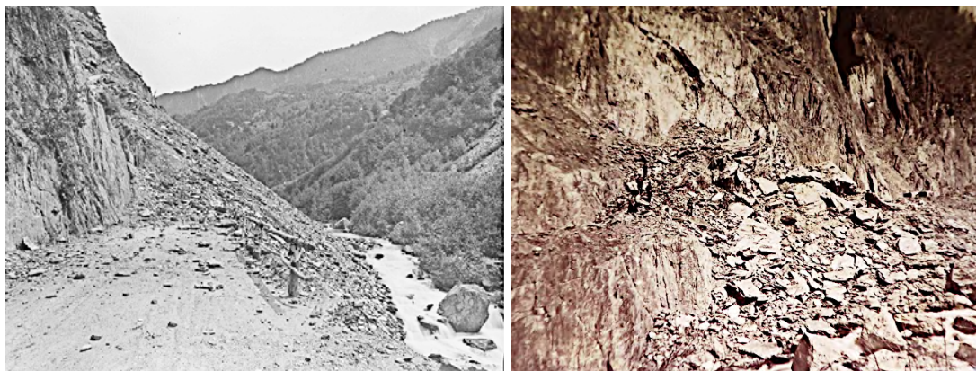
Figure 12 - Photos des éboulements de 1892 (1000 m 3 ) et 1898 (4000 m 3 ) sur la RN 202 au passage de Moulin Ravier (RTM 73, EV-1_R.0463 et AD 73, 8 SPC 33)
