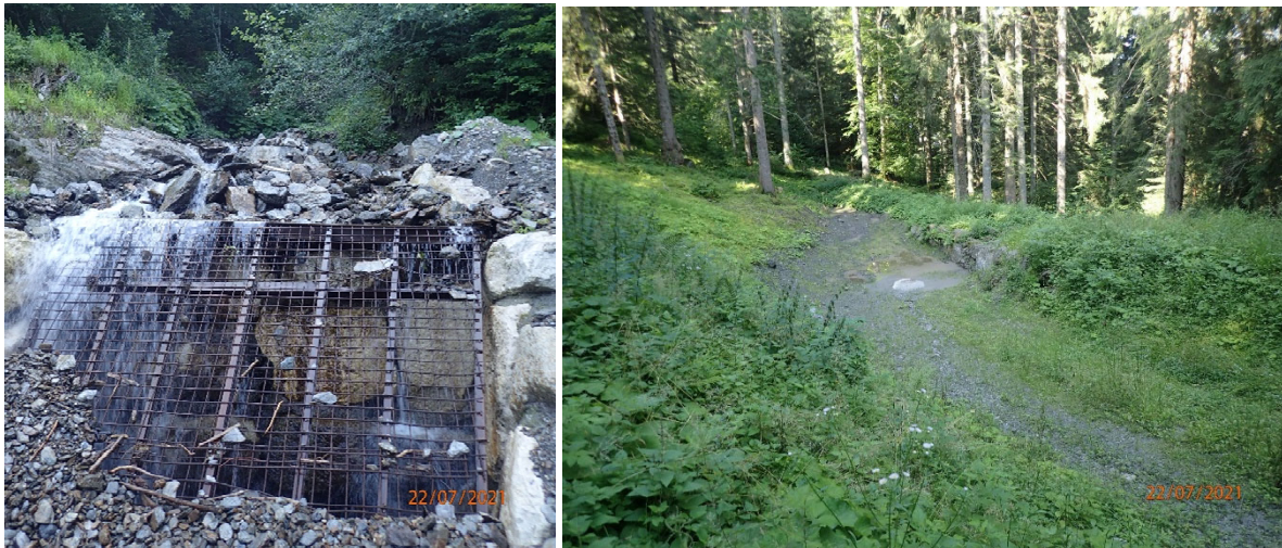
FIGURE 24 : Chariage constaté des eaux d'écoulement, sur un cours d'eau pérenne (Nant de Roches en photo de gauche) ou provisoire comme à l'ouest des Grangettes (photo de droite)
