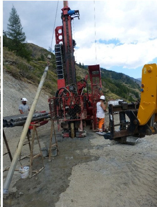
FIGURE 20 : Situation du piézomètre et foration en cours
