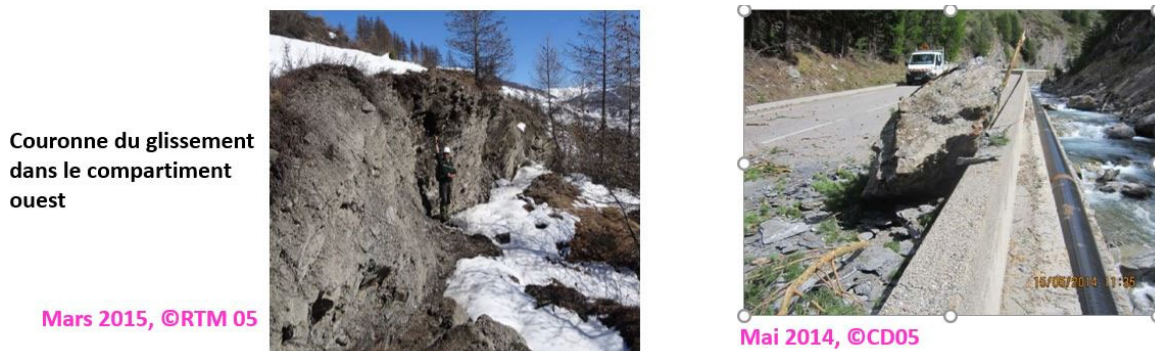
Figure 25 : Indices d'instabilité des terrains repérés par la RTM 05 de la réactivation
