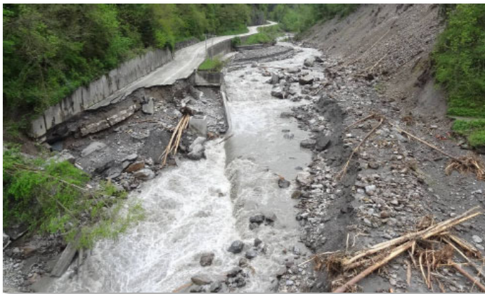
Figure 9 : Vallée de l'Arly : glissement de bas de versant par sappe de pied par la rivière Arly en crue en début mai 2015 et glissement superficiel récent sur la rive droite opposée
