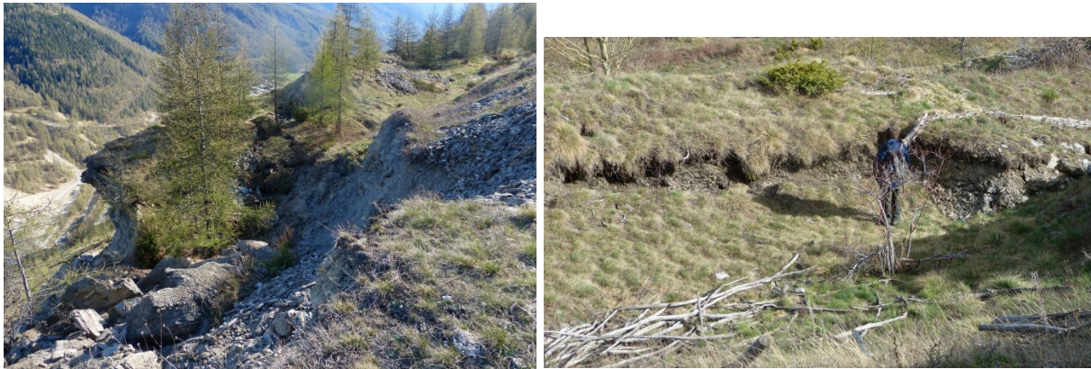
Figure 10 : Pan de versant déjà en partie remobilisé en tête du glissement du Pas de l'Ours en zone sommitale, et panneau en contre-pente préexistant crevassé en amont et avec contexte endoréique, a priori issue de l'activité passée du paléoglisserment
