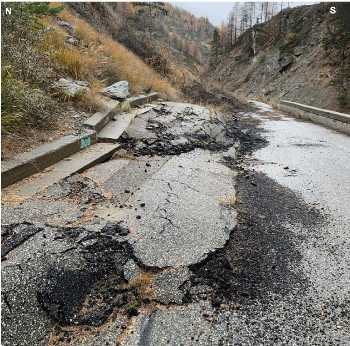
Figure 31 - Chaussée déformée par le glissement de terrain - zone centrale
