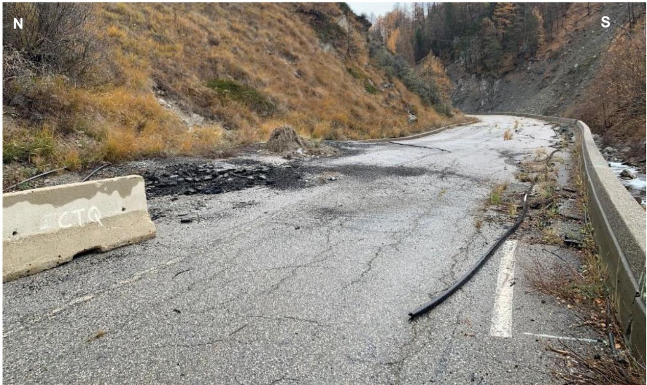
Figure 32 – Chaussée déformée à l'entrée du village avec un enrobé fracturé et une route présentant un léger devers vers le vallon
