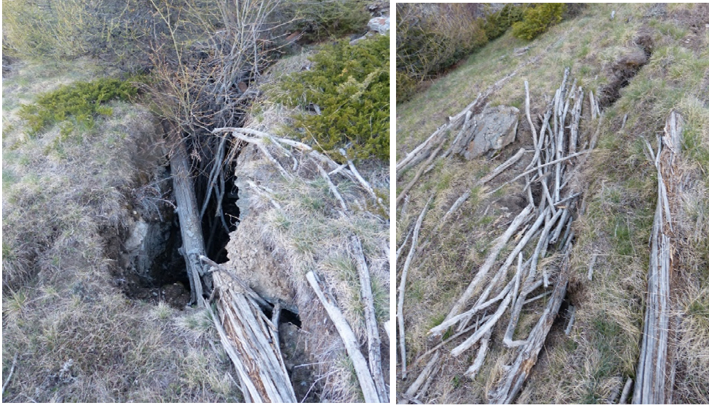
Figure 17 : pertes et fissures d'allure ancienne avec signe suspectée de réactivation récente (> 2014)
