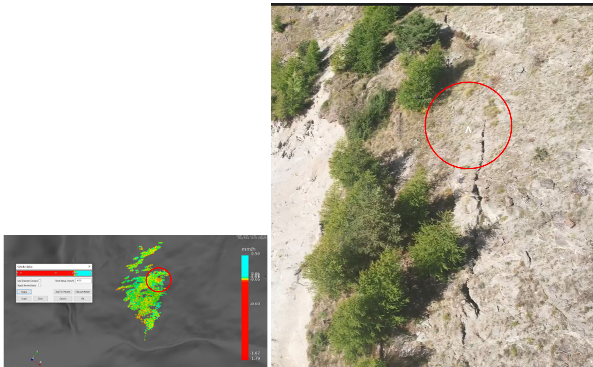
Figure 13 : Localisation de la zone ponctuellement accélérée en juin 2021 avec prise de vue photo correspondante depuis un survol drone faite par le PNRQ (fissure non présente en 2018)
