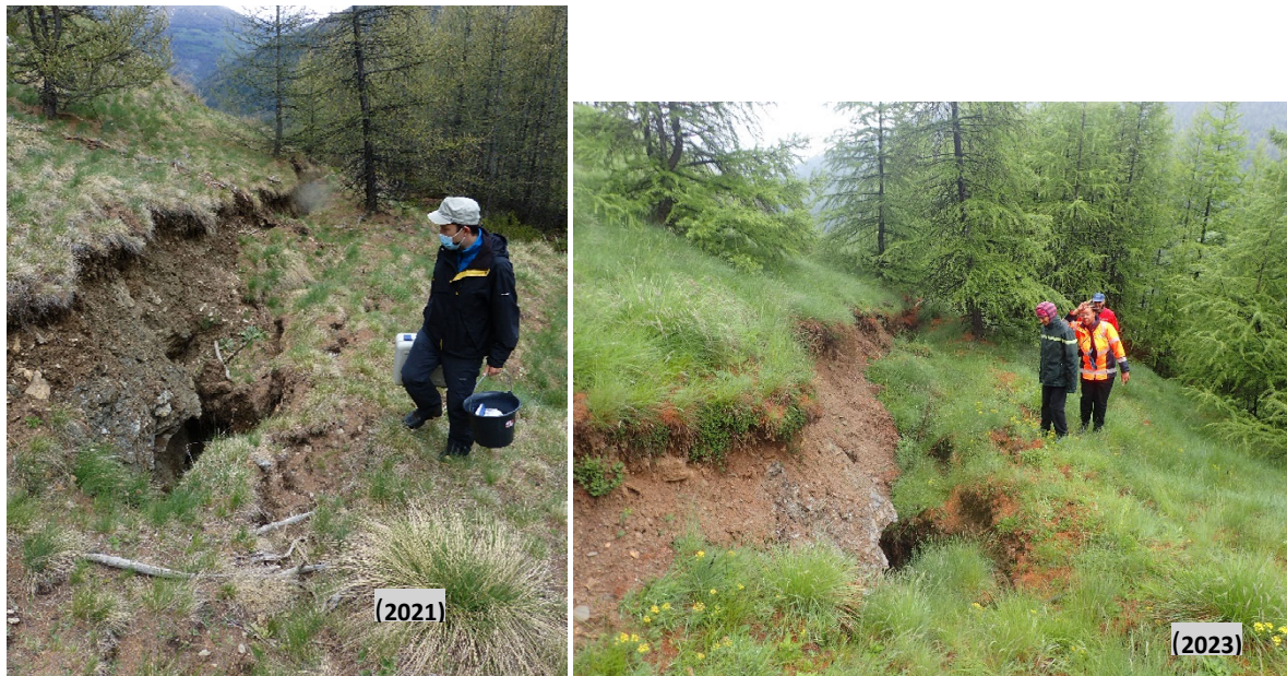
Figure 18 : pertes et fissures d'allure ancienne montrant des signes d'évolution depuis 2021.
