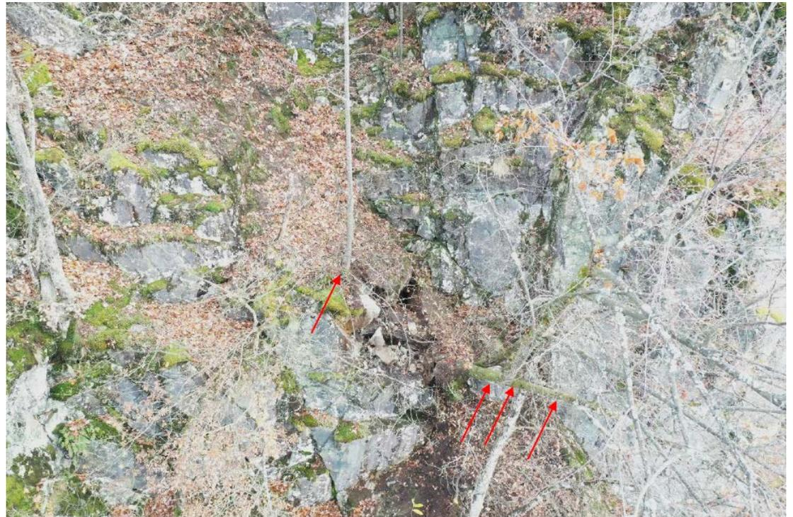
Exemple d'une chute de blocs survenue fin novembre 2023 sur la D114 St Barthélémy de Séchilienne engendrée par la déstabilisation d'un compartiment rocheux par un arbre contigu
