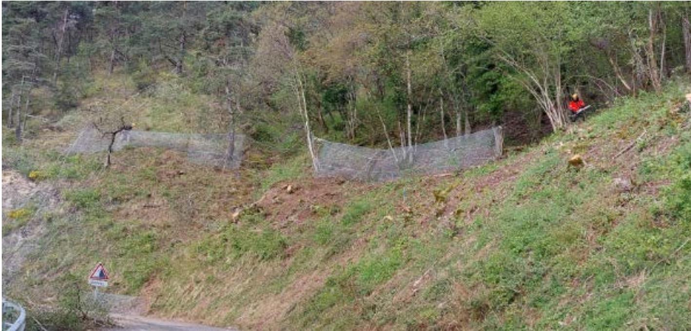
Ecrans forestiers provisoires mis en œuvre pour sécuriser les intervenants dans le cadre du chantier de sécurisation contre les chutes de blocs sur la D242 à Miribel Lanchâtre
