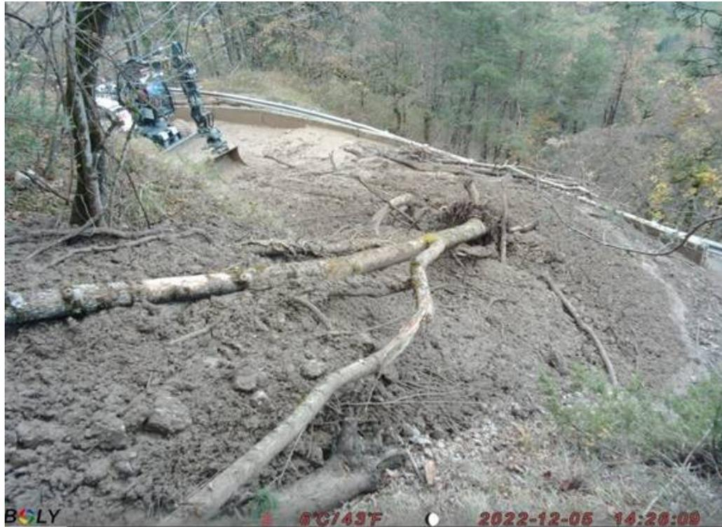
Exemple d'entraînement de branches et d'un arbre entier dans le couloir de propagation jusqu'à la chaussée avec impact sur DR lors d'une coulée boueuse de 173 m<sup>3</sup> survenue fin sur la D242 à Miribel Lanchâtre
