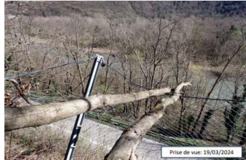
Exemple de chute d'arbres sur écran pare-blocs sur la D1091
