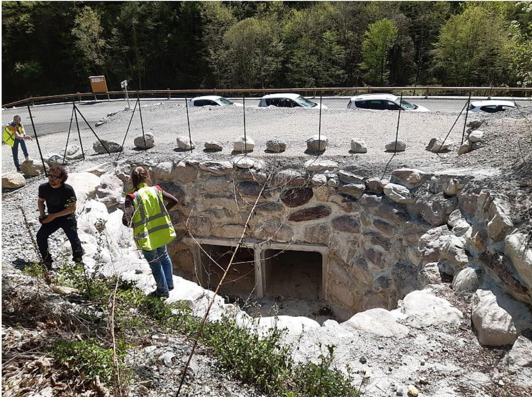
Figure 11 : Entonnement de l'ouvrage hydraulique
