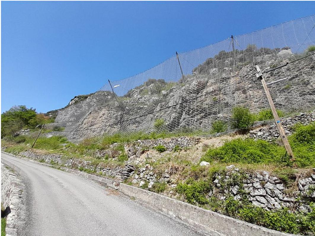
Figure 9 : Ouvrage de protection hybride (écran / déflecteur)
