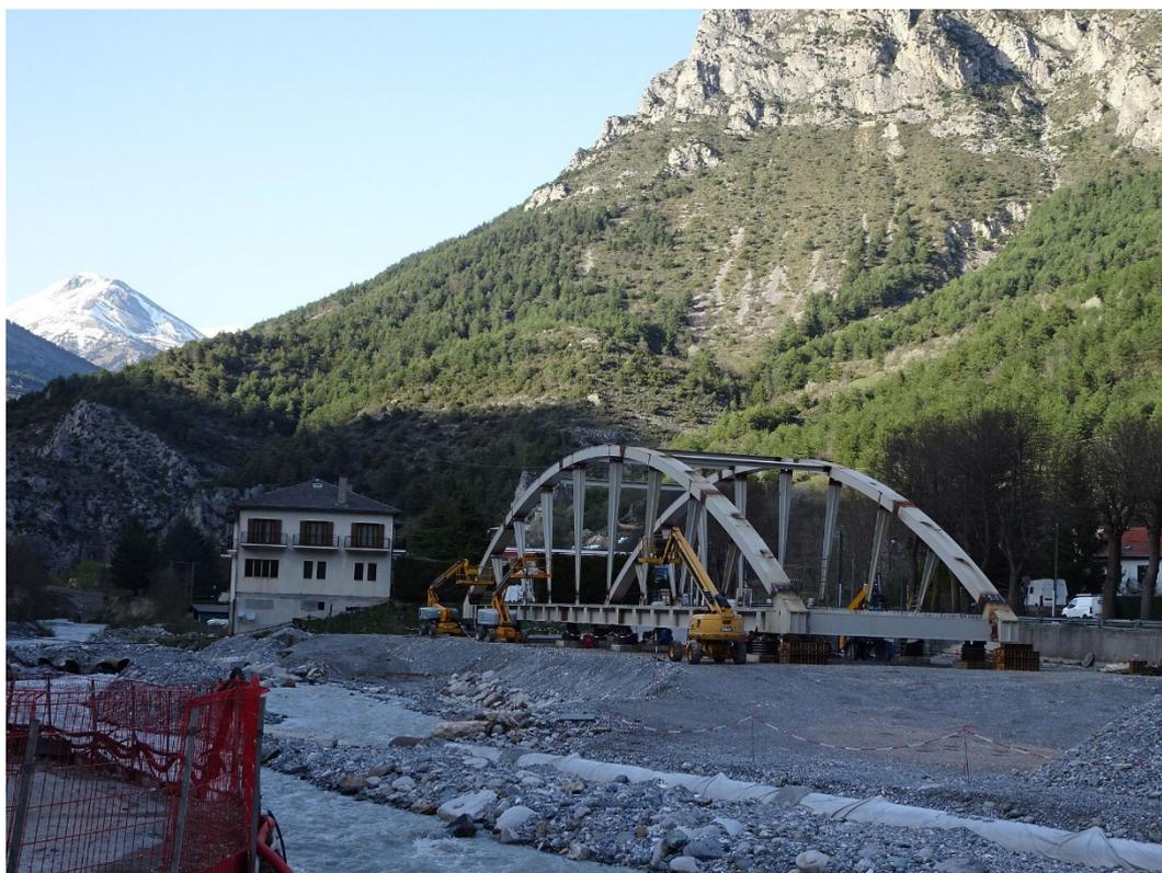
Figure 9a : pont Bow-String en cours de construction
