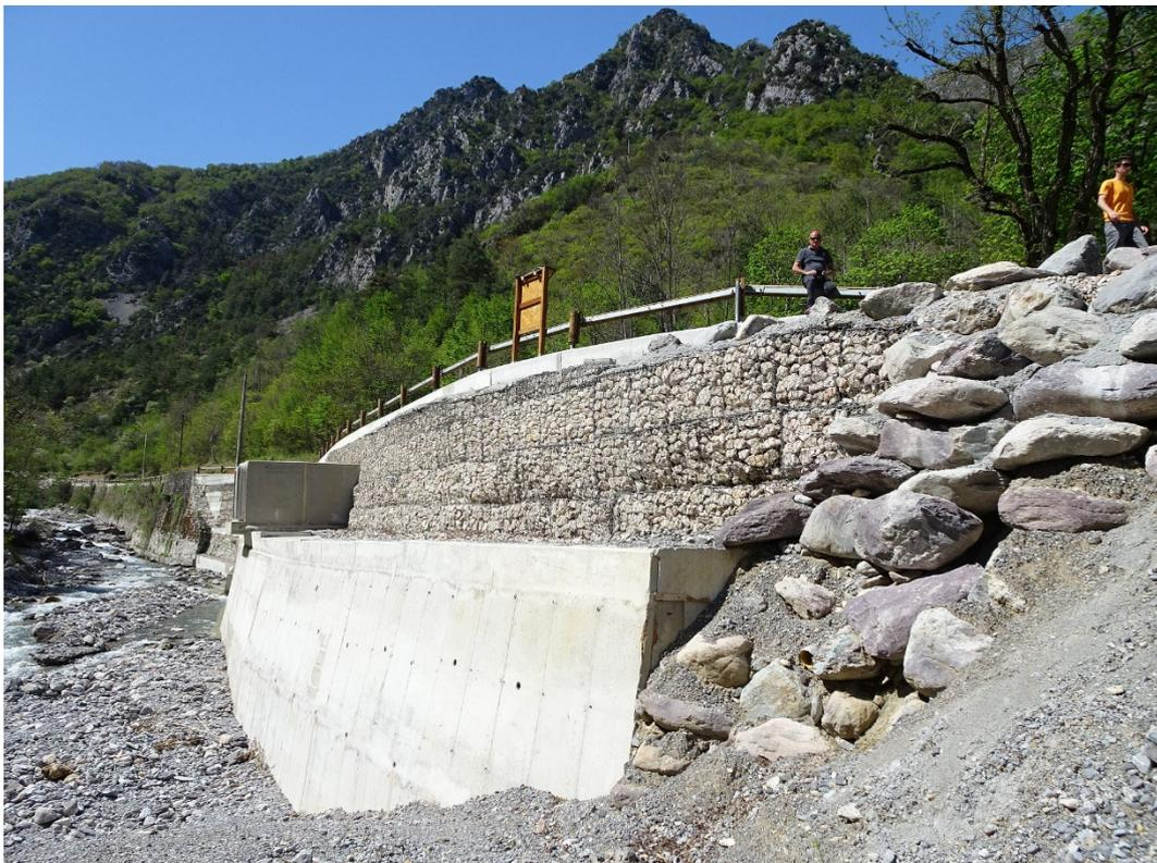
Figure 10 : Ouvrage de soutènement sortie ouvrage hydraulique
