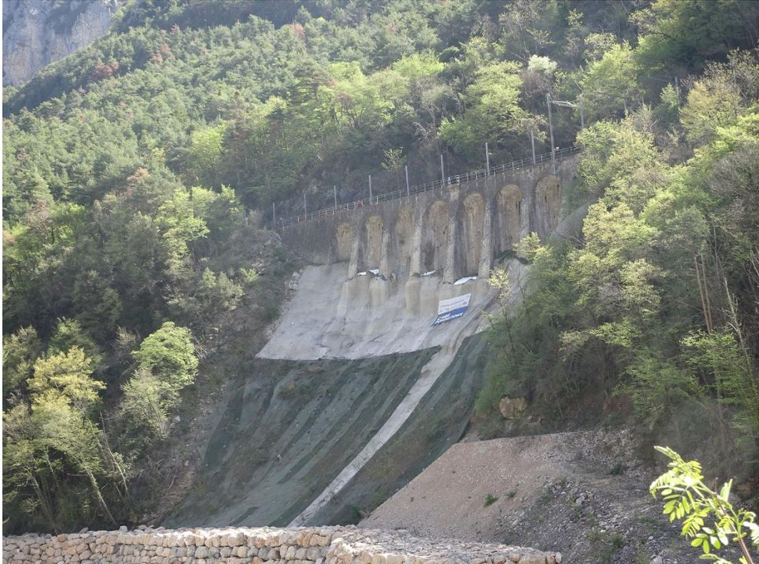
Figure 10 : Mur à arcatures supportant la voie SNCF
