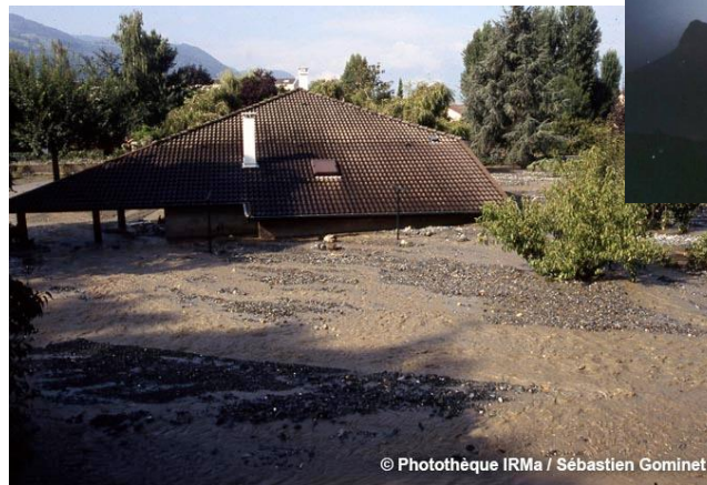
Crue torrentielle du Doménon, 2005
