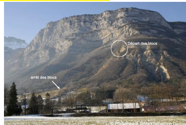
Risques de chutes de blocs à Saint-Paul-de-Varces
