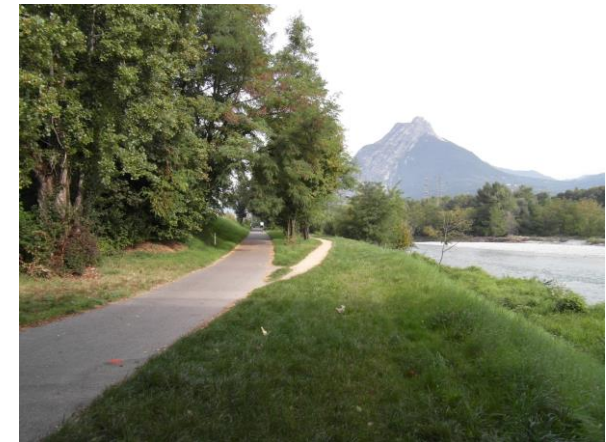
Digues du Drac
