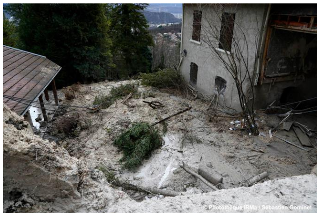
Glissement de terrain à Claix, 2018
