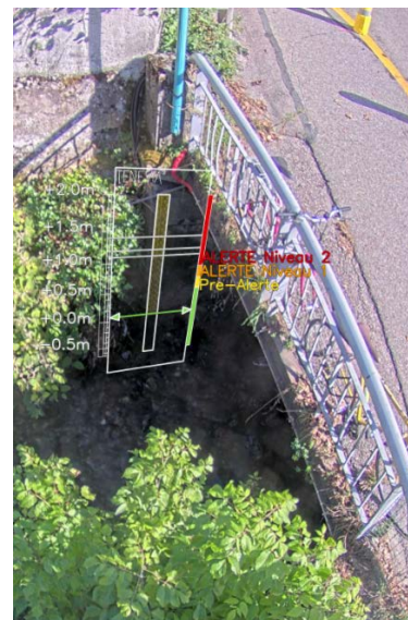
Station du pont de Venon
