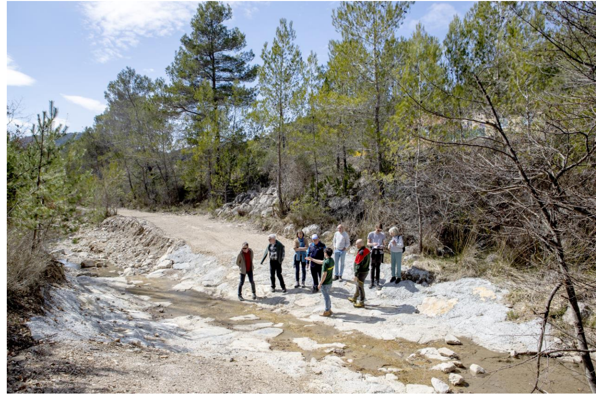
Piste et passage à gué réalisés suite à l'étude pour la Mise en sécurité du massif de Pierrelongue (GIRN 2017-2020)
