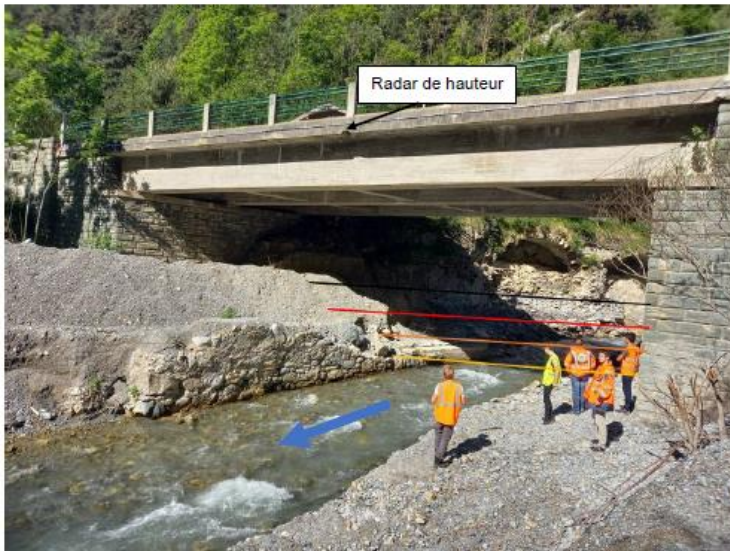
Photo prise de l'aval direct du pont, vue vers l'amont (04-06-2021).
