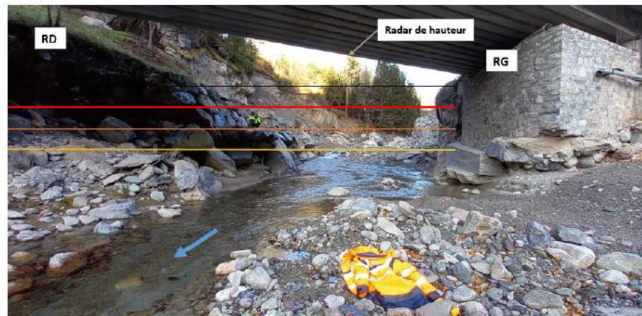
Photo prise de l'aval direct du pont, vue vers l'amont (29-12-2021).
