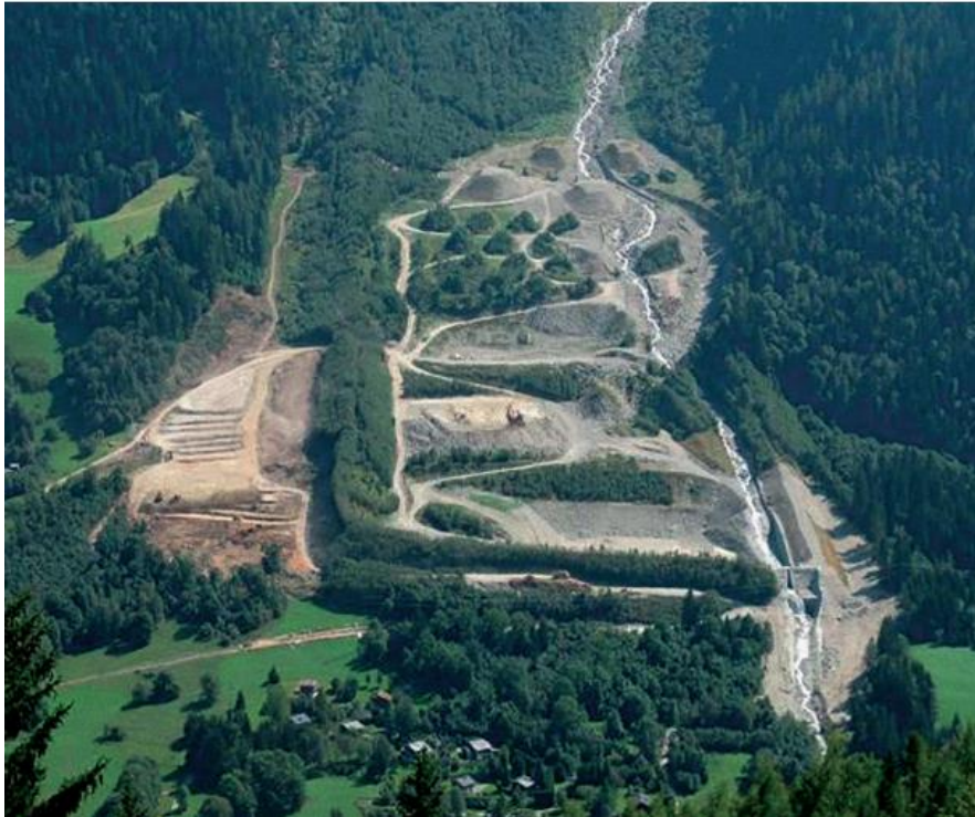
Photo 7 : Vue d'ensemble des ouvrages du paravalanche de Taconnaz (Glacier-climat.fr, 2022).
