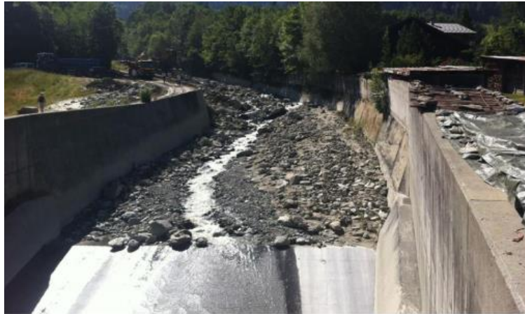
Photo 9 : L'impressionnant « pont rivière » au-dessus de la N205 (SM3A, 2023).
