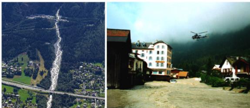
Photo 5 : A gauche : le torrent de la Creuse traverse à trois niveaux la N205 sous des ponts cadres (Wikipédia, 2023). A droite : inondation de 1996. Vue du centre-ville de Chamonix (Le Dauphiné Libéré, 08/10/2020).
