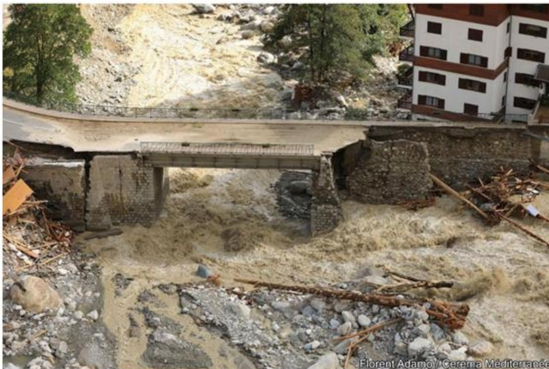
*Photo 1 : Vue amont du pont de Venanson sur la commune de Saint-Martin-Vésubie (Queffelec et al., 2022). Le pont endommagé ne permet plus de relier le centre de la commune aux quartiers périphériques. Celui-ci sera démantelé le 22 octobre 2021.*
