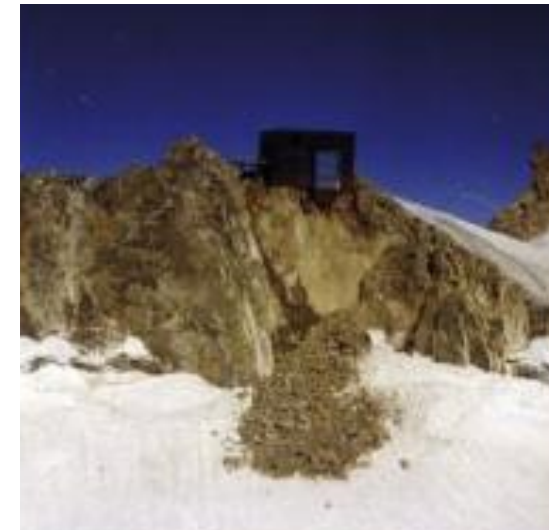
Écroulement de 600 m 3 sous le refuge en 1998 (Allen et al., 2012)
