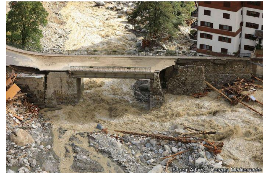
Vue amont du pont de Venanson sur la commune de Saint-Martin-Vésubie (Queffelean et al. , 2022)
