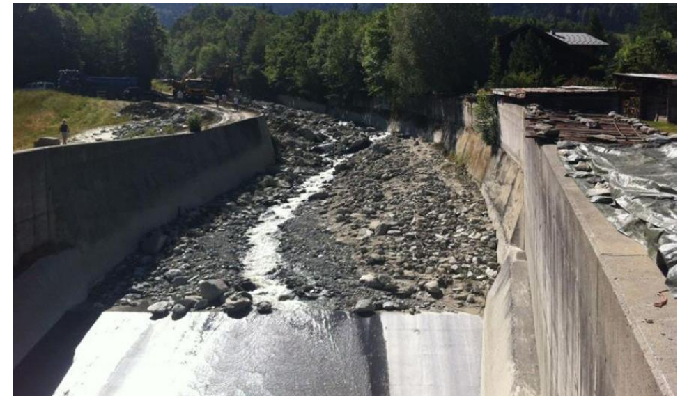
Pont rivière au-dessus de la N.205 (SM3A, 2023)
