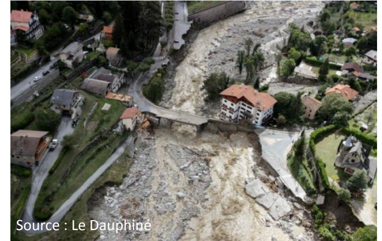
Dégâts à Saint-Martin-Vésubie
