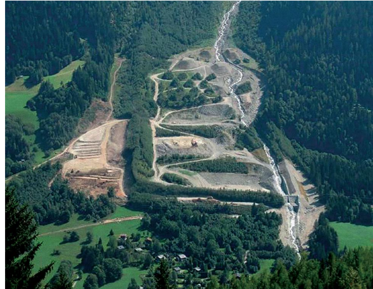
Vue d'ensemble des ouvrages (Glacier-climat.fr, 2022)
