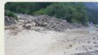
D994G coupée par une coulée du torrent de la Ruine au hameau de Roucy (Val-des-Prés) en juillet 2018 (Photo : Le D1 / J.M.)
