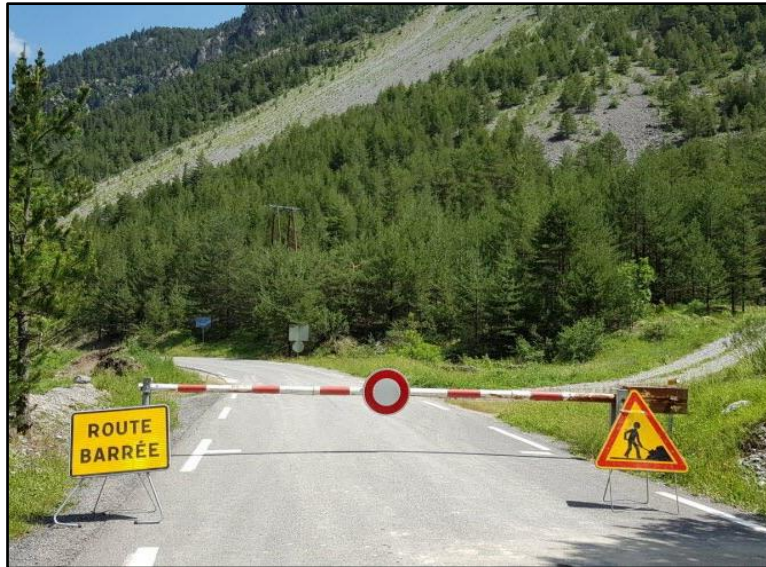
D994G en travaux à la suite d'une coulée boueuse bloquant la voie (Archives photo Le DL /Clarisse PORTEVIN)
