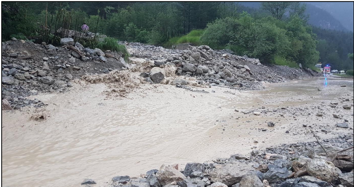
RD994 G coupée par une coulée du torrent de la Ruine au hameau de Rosier (Val-des-Prés) en juillet 2019 (Photo : Le DL / J.-Y.G) Source : https://www.ledauphine.com/hautes-alpes/2019/07/03/meteo-val-des-pres-coulee-de-boue-dans-la-vallee-de-la-claree-nevache-encore-isolee
