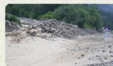
D994G coupée par une coulée de torrent de la Rivière du Hammeu de Rosier (Val-des-Prés) en juillet 2019 (Photo: Le DL / J.-M.)
