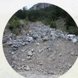
Coulée de lave torrentielle ayant atteint la chaussée entre Val-des-Prés et Névache en août 2018 (Photo: Le DL / J.M.)
