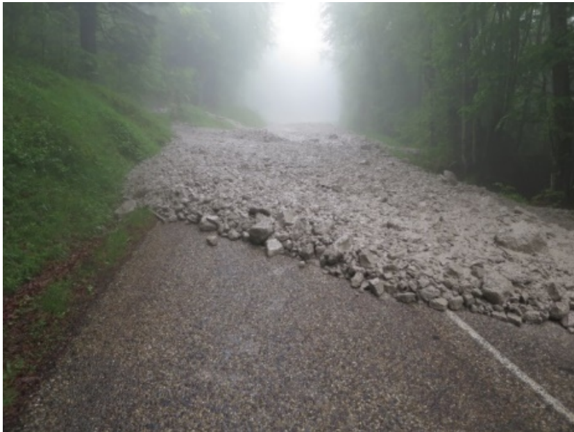
Lave torrentielle du torrent des Glacières ayant coupé la route départementale
