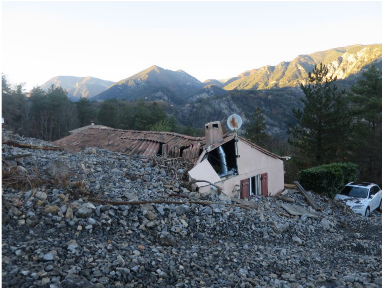
Tempête Alex — Commune de Malaussène — Maison détruite à l'aval d'un ravin jusque là peu actif...
