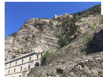
Fort Tournoux (Condamine-Châtelard)
