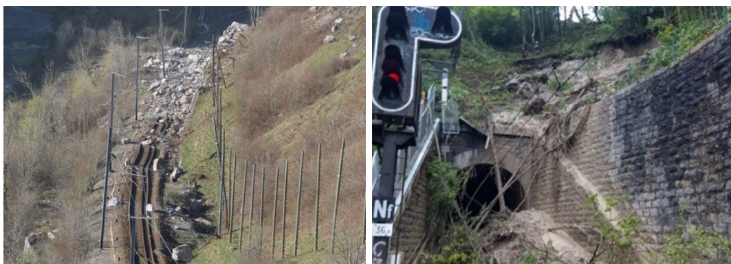
Figure 9 : A gauche : Eboulement sur la ligne ferroviaire reliant Bourg-Saint-Maurice à Moûtiers les 7 et 8 avril 2015. ©www.ter.sncf.com/ A droite : Glissement de terrain au-dessus du tunnel de Brassilly sur la ligne TER entre Aix-les-Bains et Annecy, le 2 mai 2015. © www.ter.sncf.com/
