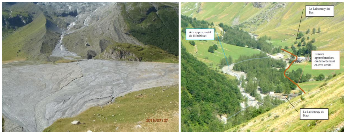
Figure 11 : Photo de gauche : Dépôt de matériaux au niveau du lac de la Glière (in: Jullien, 2015b). Photo de droite : Débordements au niveau du Laisonnay (in: Jullien, 2015a). © RTM73.
