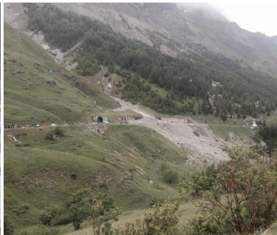
Figure 14 : La RD1091 coupée par les dépôts de lave torrentielle du Rif Blanc au-dessus de Monétier-les-Bains, à proximité du col du Lautaret (Hautes-Alpes). En haut : ©BFM-TV, 15/06/2015. A gauche : Dauphiné Libéré. A droite : Ici.fr. Grâce à la présence d'une ancienne galerie, qui a tout de même été en partie inondée, la circulation n'a été que brièvement interrompue.
