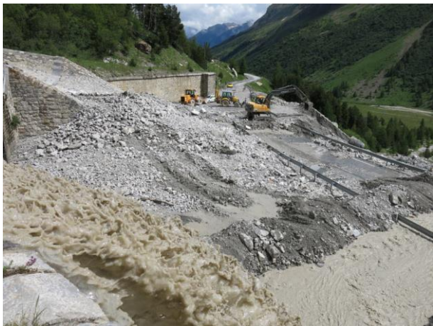
Figure 14 : La RD1091 coupée par les dépôts de lave torrentielle du Rif Blanc au-dessus de Monétier-les-Bains, à proximité du col du Lautaret (Hautes-Alpes). En haut : ©BFM-TV, 15/06/2015. A gauche : Dauphiné Libéré. A droite : Ici.fr. Grâce à la présence d'une ancienne galerie, qui a tout de même été en partie inondée, la circulation n'a été que brièvement interrompue.
