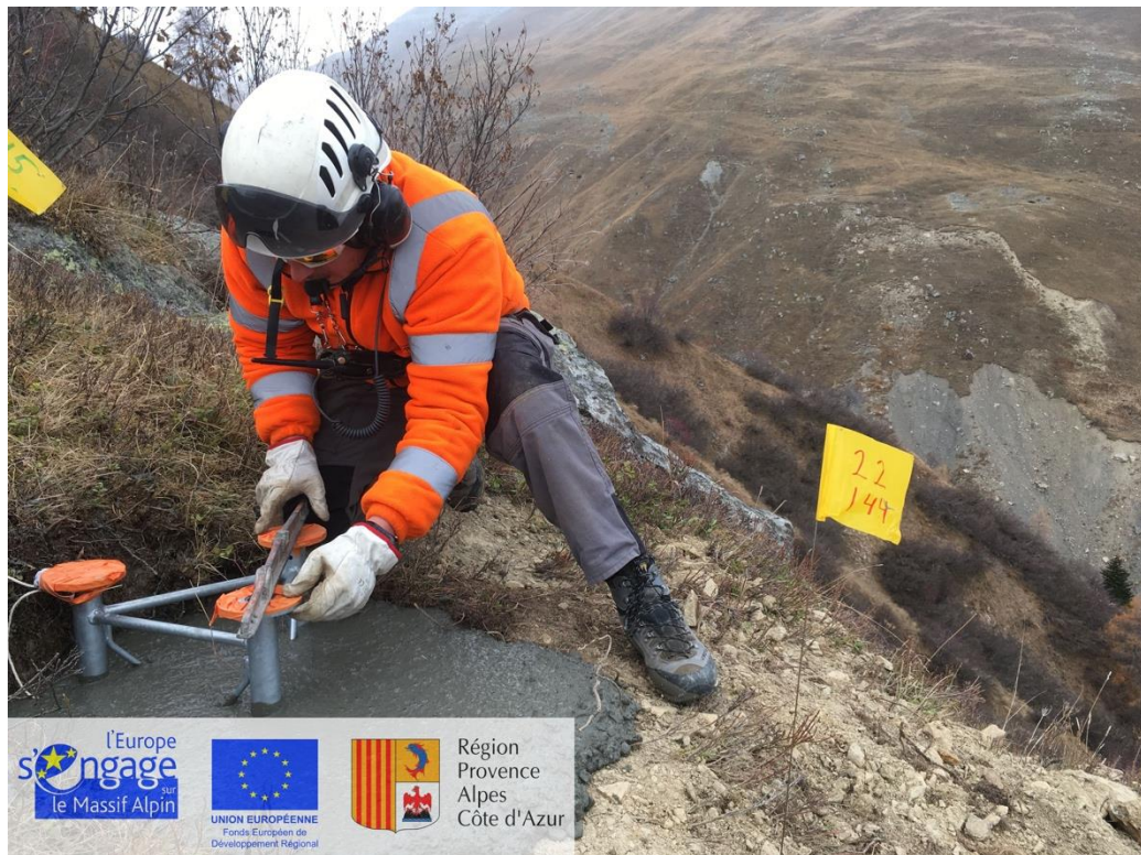
Figure 8 : Installation des embases sur socle en béton pour installation des mats supportant les appareils photos
