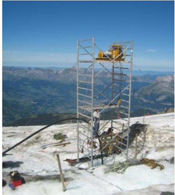
Une fois la première pompe en service, la question de la stabilité de la voûte de la cavité de glace s'est posée à partir du moment où le plafond ne serait plus maintenu par la pression de l'eau. En effet à partir de cet instant, un risque de rupture brutal existait.
