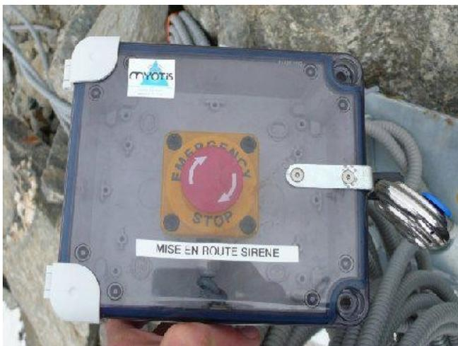
Un boîtier manuel est également situé sur le glacier au niveau de l'armoire MYOTIS de détection amont en rive droite du Bossonet (mis sous clef).
