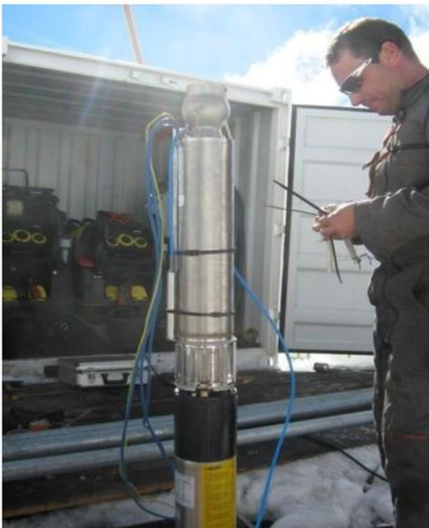
Au fur et à mesure de la réalisation des puits, des pompes de refoulement étaient descendues dans la poche d'eau.
