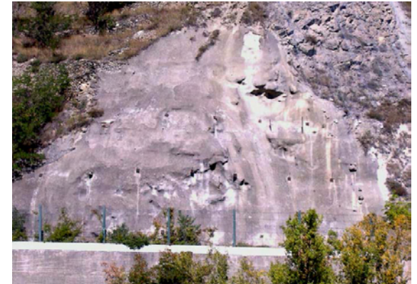
Béton projeté sur treillis d'armature ancré
