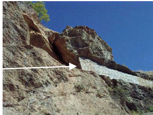
Contrefort en maçonnerie
