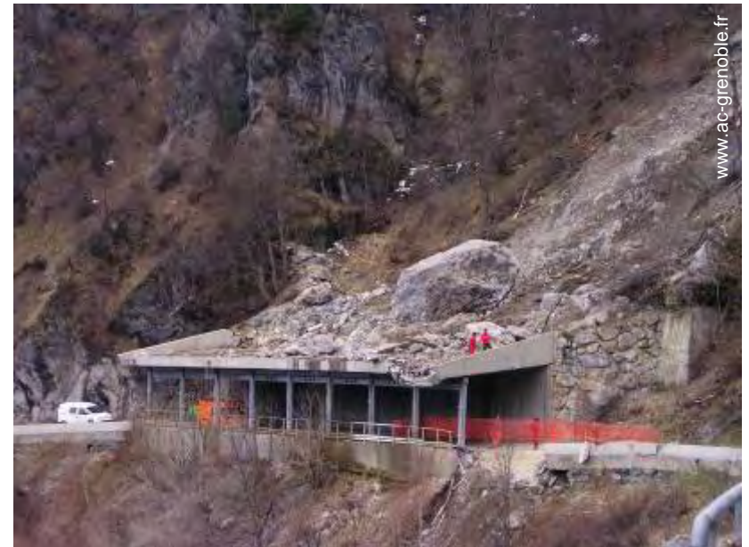
Chute de blocs sur un paravalanche
