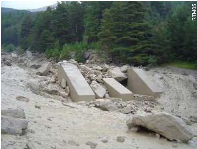
Plage de dépôt, torrent du Verdarel (dépôts de la crue du 1er sept. 2005)
