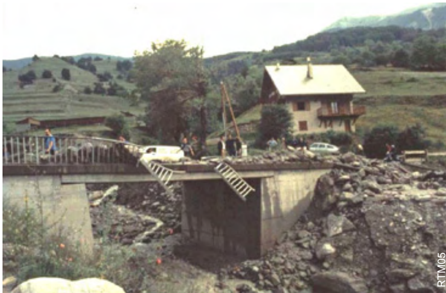
Torrent du Verdarel à Saint-Chaffrey (05) : crue du 9 juillet 1981
