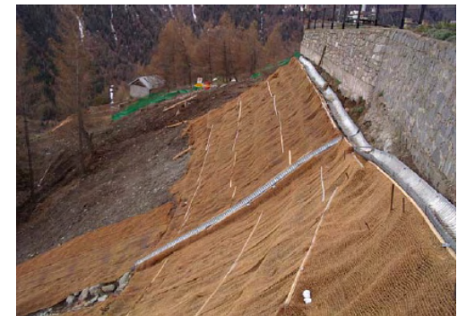
Chenaux métalliques et géotextile
