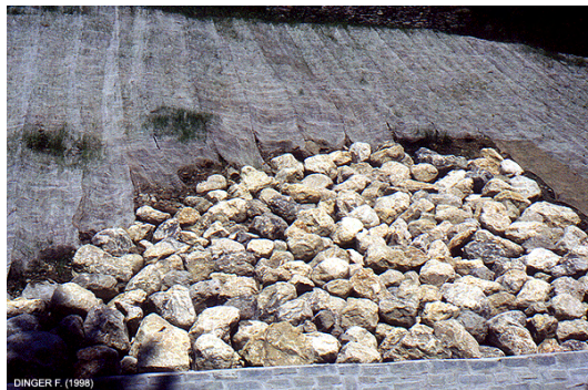
Massif drainant et géotextile avant revégétalisation
