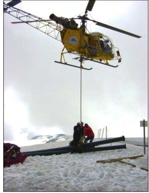
▲ *Le campement au bord du col glaciaire et l'hélicoptage des tuyaux Ø 200 pris à l'arrivée aval du conduit et ramenés au bord du lac pour remplacer les éléments amont détruits suite à la déformation imposée par la charge de neige durant l'hiver.*
