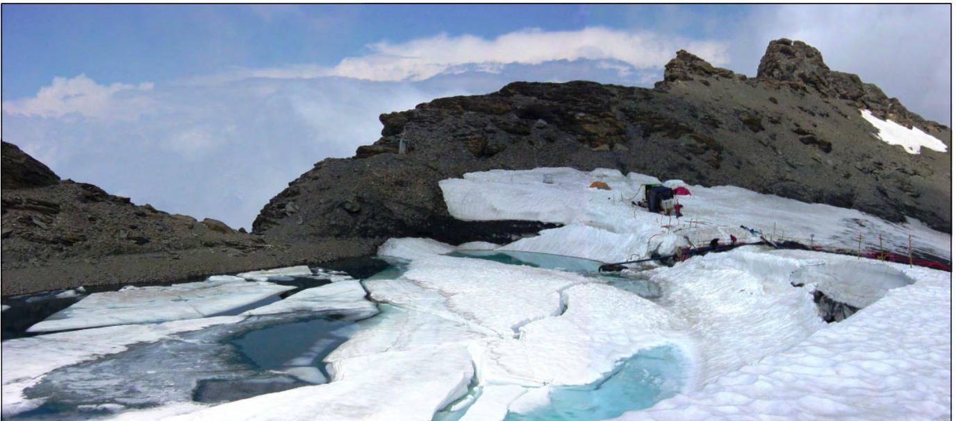
**Le 5 juillet au matin**, les siphons Ø 200 sont remis en action. La revanche imposée à l'entreprise est désormais d'au moins 1 m entre le niveau du lac et le fond de la tranchée. Il s'agit en effet d'avoir une marge suffisante en cas d'arrêt des siphons, notamment pendant les deux jours d'arrêt de chantier en fin de semaine.
