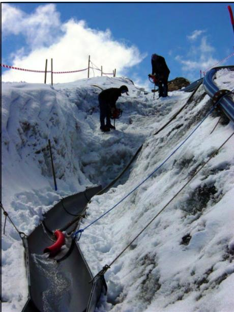
◀ **Réalisation des trous de mine dans le verrou de sécurité amont de tranchée, et explosion de la charge** ▼
