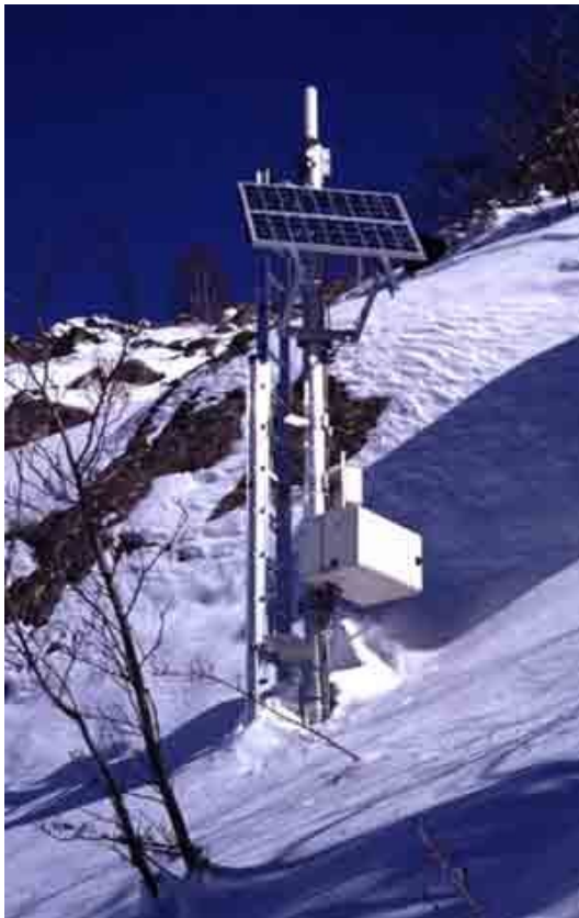
Balise de détection sismique des avalanches
