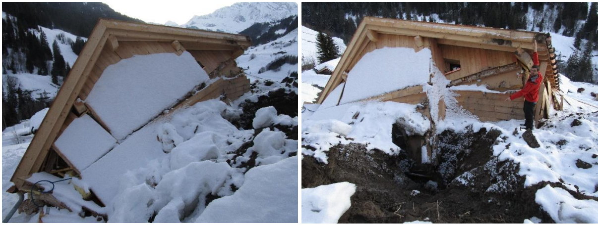
Figure 15 : Glissement de terrain de la Giétaz (73).
