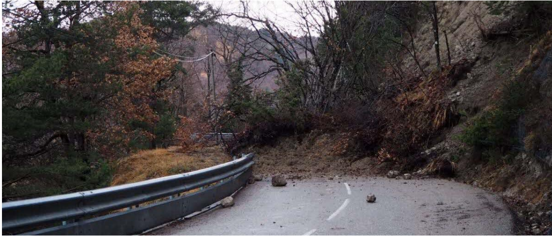
Figure 22 : Exemples d'impacts des événements de janvier sur la Métropole de Grenoble (crue de l'Isère, coulée de boue sur la RD8, chutes de blocs sur le RD57).
