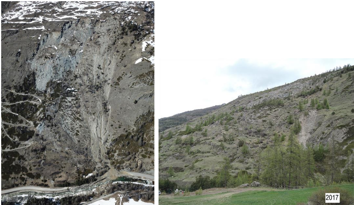
Figure 16 : Glissement de Pas de l'Ours.
