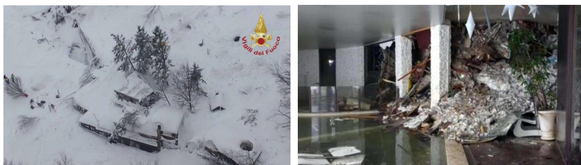
Figure 15 : photo aérienne et photo de l'hôtel Rigopiano suite à l'avalanche du 18 janvier 2018 en Italie.
