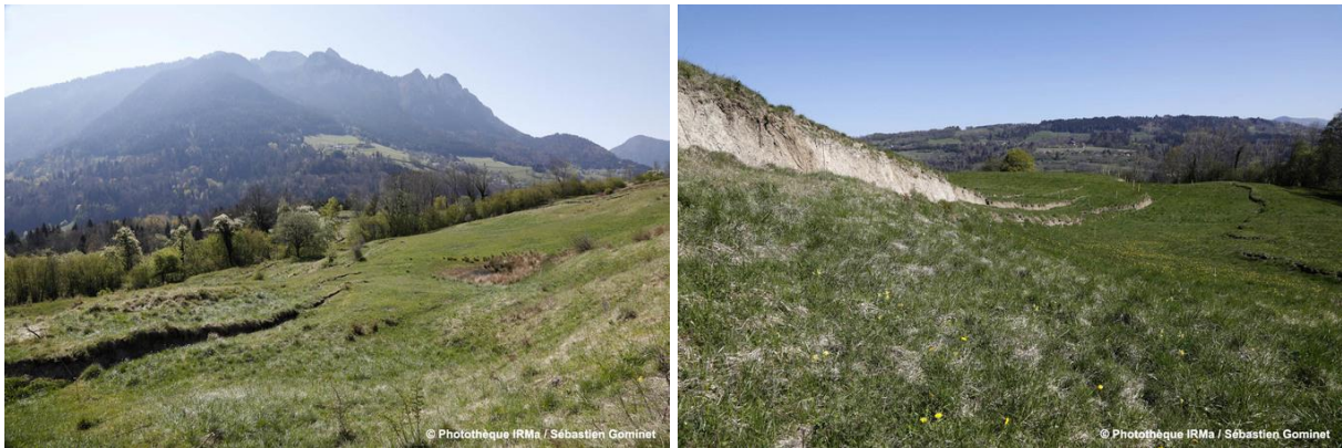
Figure 19 : Glissement de Reyvroz. Source : Sébastien Gominet, IRMa.
