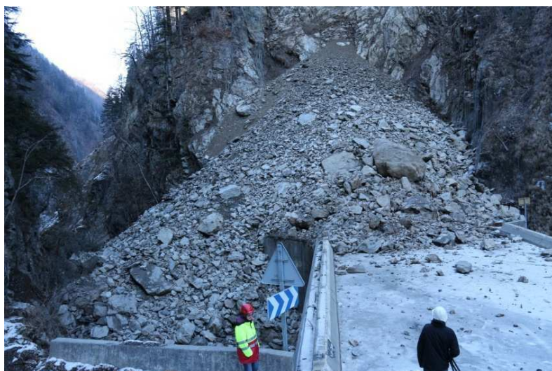
RD1212– Les Cliets Val d'Arly Eboulement de 8000 m3 - janvier 2014
