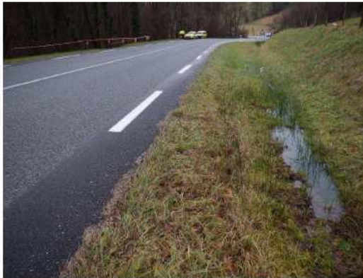
Résurgence en PR amont - cunette amont
