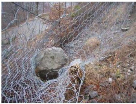
**Fig. 27.** Exemples de chutes de blocs sur des routes en Savoie en janvier 2011
