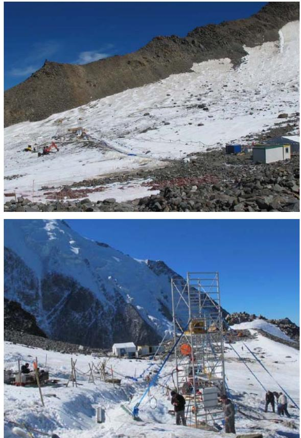
Fig. 35. Vidange artificielle de la poche par pompage entre le 25 août et le 15 octobre 2010
