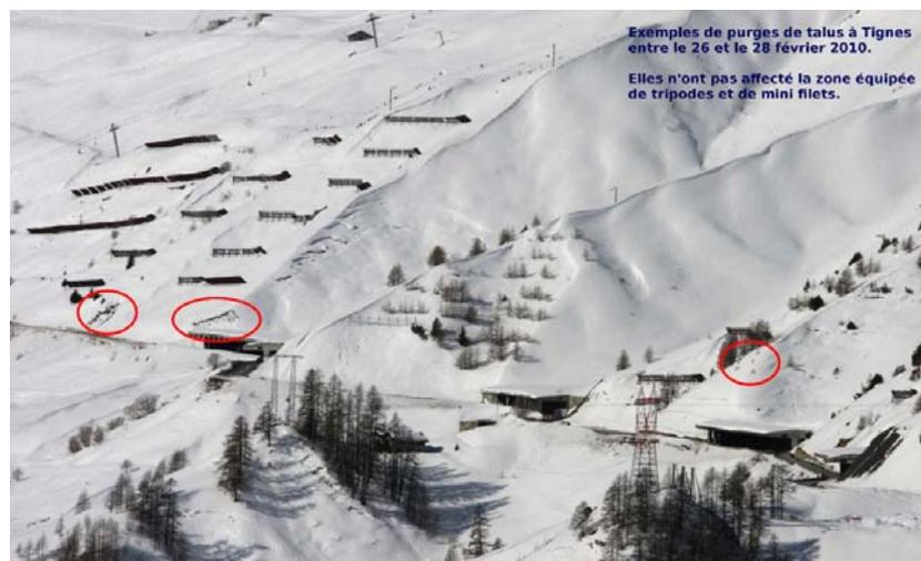
**Fig. 28.** Ouvrages de protection contre les avalanches (Tignes)
