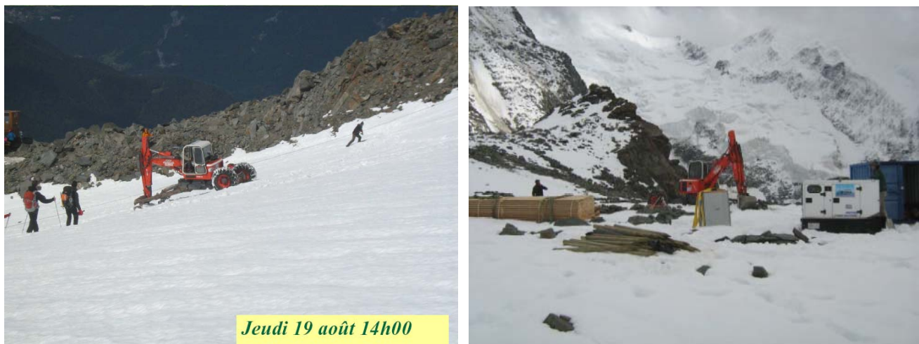
Fig. 17. Arrivée de la pelle araignée sur le glacier (assistée par un câble) et montage des installations du chantier dès 17h00
