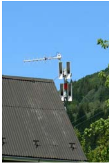
Fig. 43. Exemple d'installation d'une sirène sur un toit
