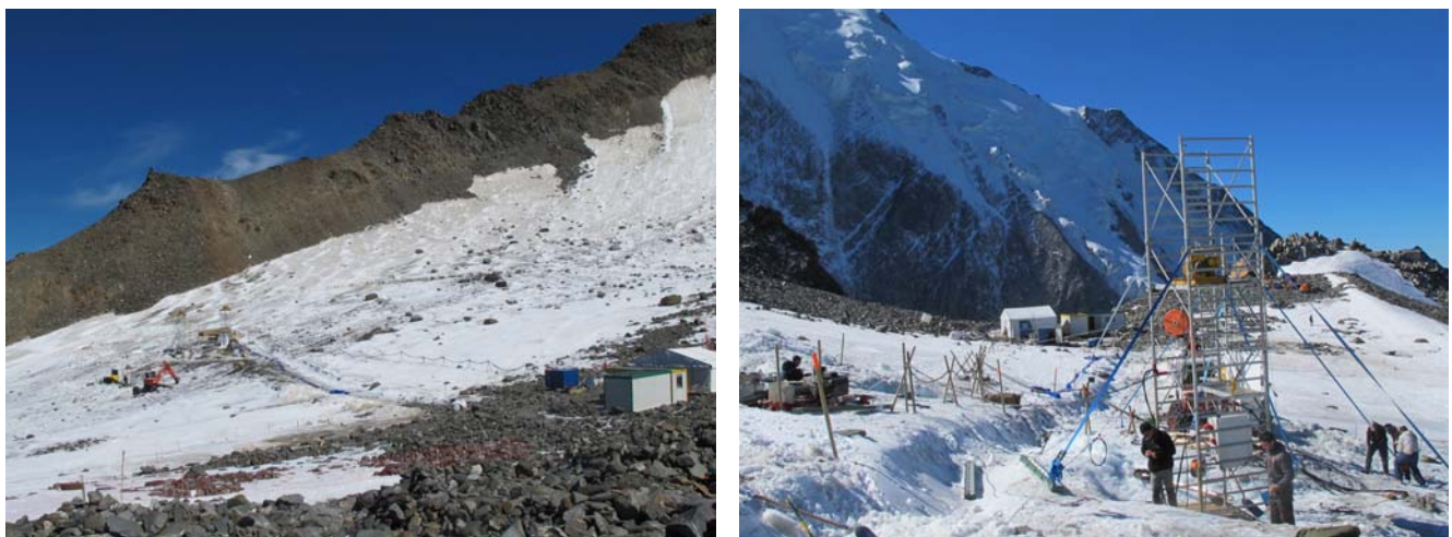
Fig. 11. Travaux de vidange de la poche d'eau du glacier de Tête Rousse pendant l'été 2010
