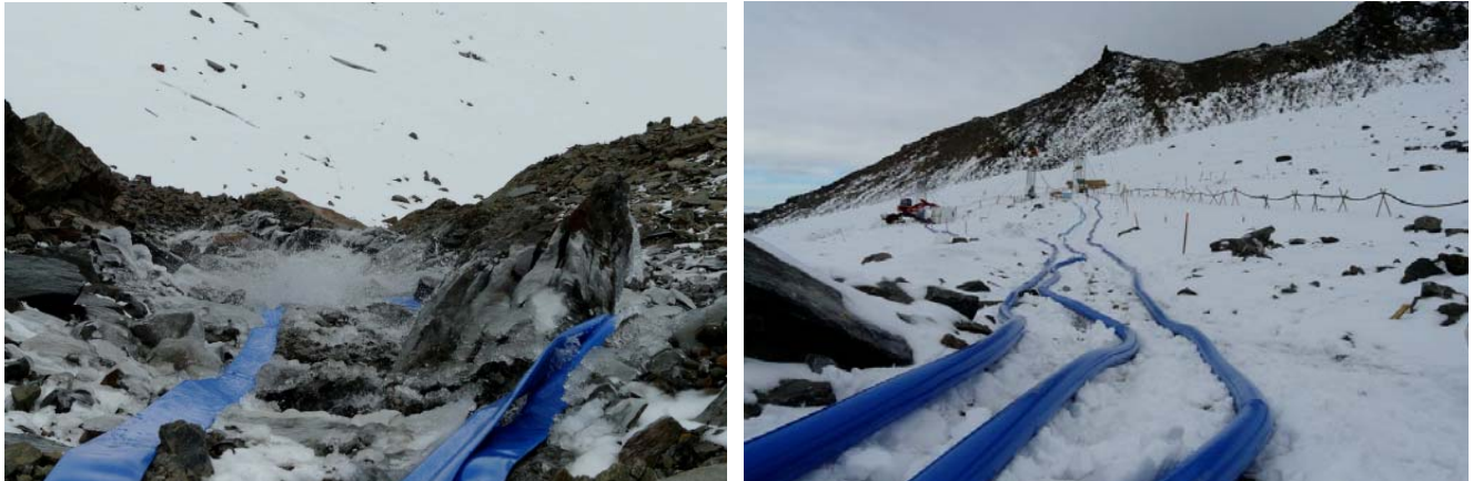
Fig. 24. Mise en œuvre du pompage
