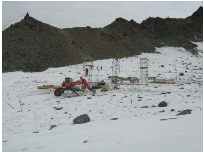
Fig. 22. Installation de tours de levage pour réaliser les forages
