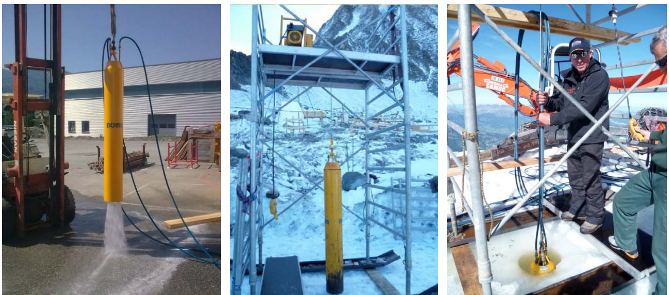
Fig. 20. Le forage à l'eau chaude sous pression (brevet BOMA)
