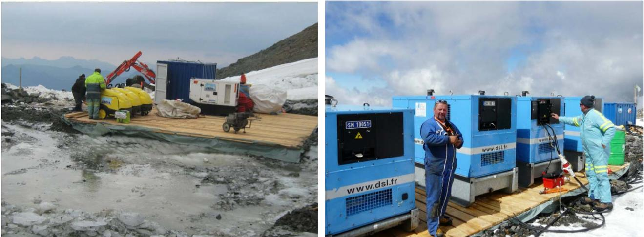
Fig. 18. Plateforme pour les groupes électrogènes
