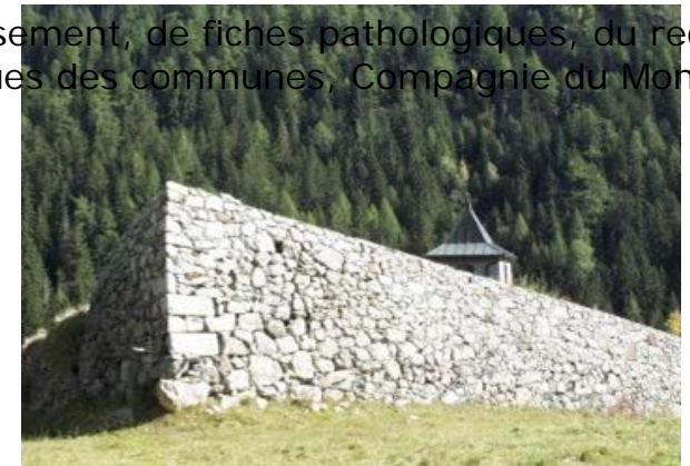
Mur paravalanche de l'Eglise de Vallorcine
