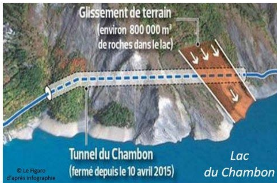
Glissement de terrain au tunnel du Chambon
